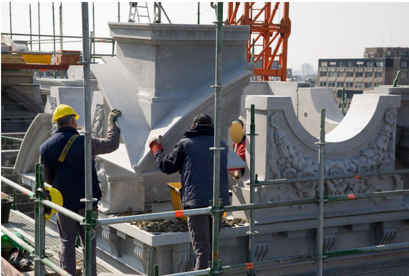
Figuur 5: Centraal Station Antwerpen: montage van de elementen in kunststeen. Bron: PETERS S. 2013: Gietwerk: Siliconen en EPS gietmallen voor monumentale ornamenten in kunststeen. Casestudie: Centraal Station Antwerpen, Handboek Onderhoud, Renovatie en Restauratie Afl. 56 , III, 71.
