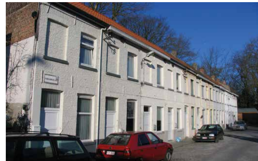
FIG. 7 Het Vandammebuik in Kortrijk, een bouwkundig geheel van veertien arbeidershuisjes gebouwd in 1882 ( https://inventaris.onroenderfgoed.be/dibe/geheel/8736 ).
