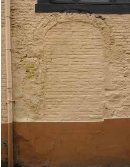
FIG. 8 Het gebouw als bron: een gedichte deuropening uit de 17de eeuw in een pand in Diest ( https://inventaris.onroerendergoed.be/dibe/relict/213176 ).
