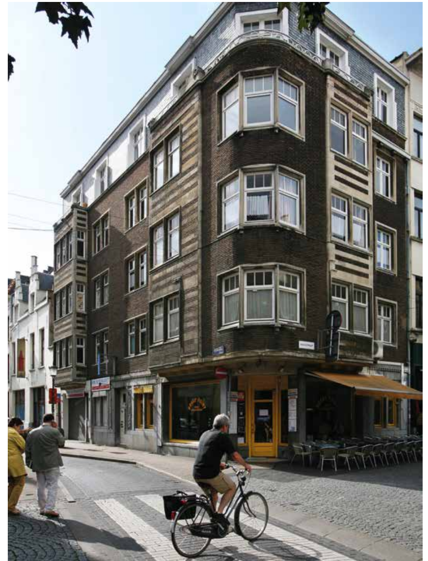
FIG. 6 Als rijzig hoekgebouw bezit dit pand in de Hoogstraat in Antwerpen een contextwaarde ( https://inventaris.onroenderfgoed.be/dibe/relict/4148 ).
