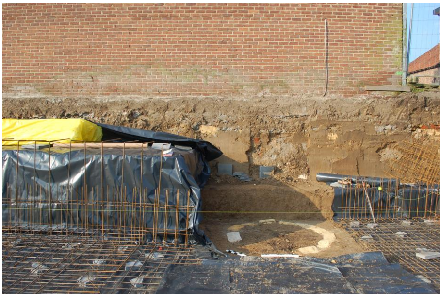
Figuur 11: De waterput op de bodem van de bouwput. (©agentschap Onroerend Erfgoed)
