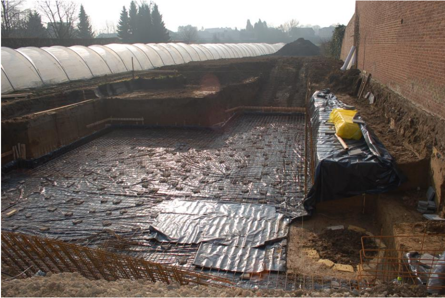
Figuur 5: De situatie op het terrein tijdens het onderzoeken van de waterput op 18/03/2015. (©agentschap Onroerend Erfgoed)
