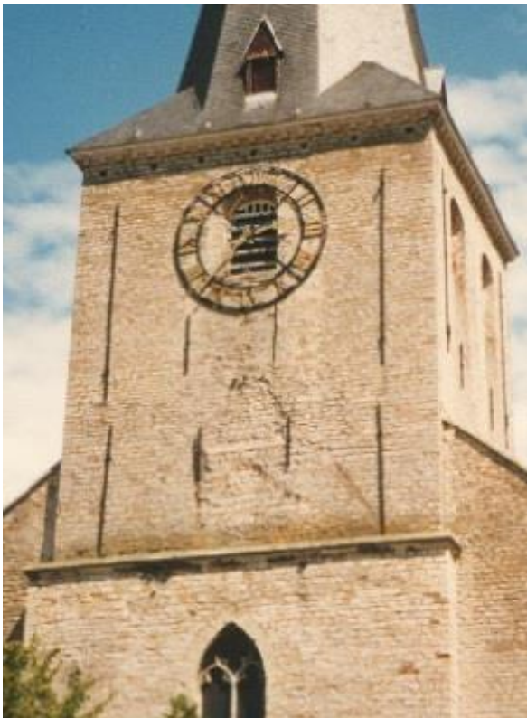
Figuur 9: De romaanse toren met op de gevel duidelijk zichtbare restanten van twee achtereenvolgende dakhellingen. (©archief gemeente Zemst)
