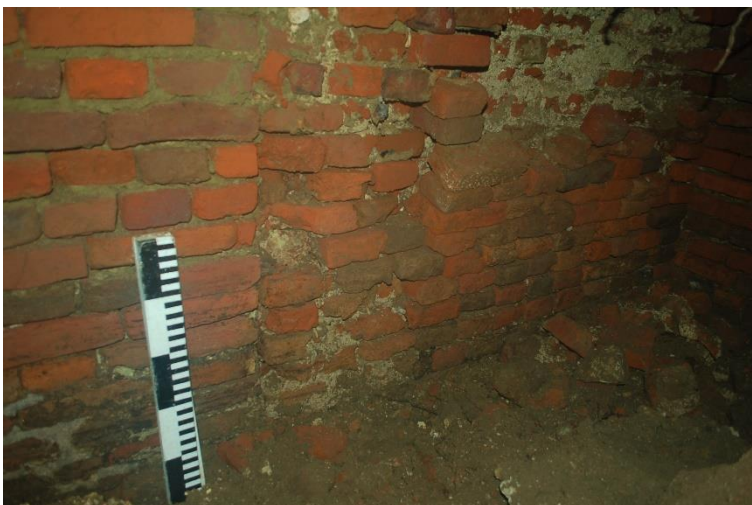
Figuur 27: Restanten van een dwarsmuur in de westelijke kelderdeur.
