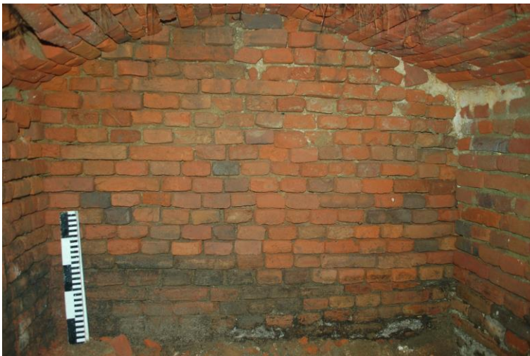
Figuur 26: Het metselwerk van de zuidelijke kelderdeur met tongewelf.
