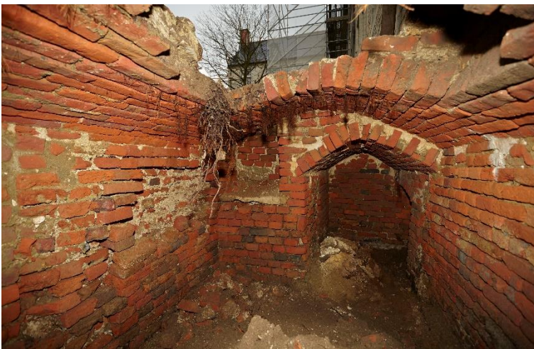
Figuur 29: De gang met zadeldak gewelf in de noordelijke muur van de kelder.
