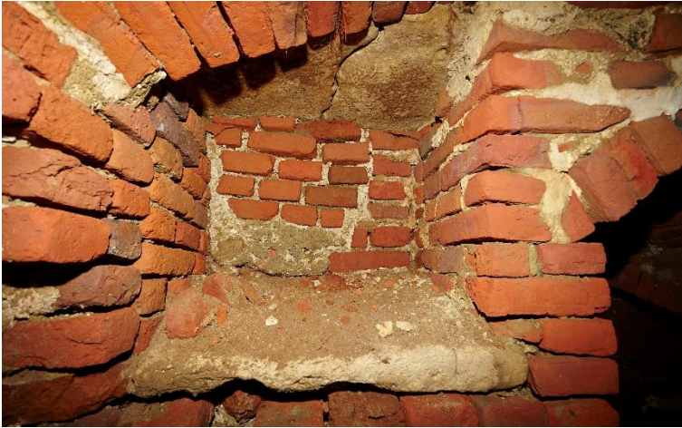
Figuur 28: Uitgespaarde nis of keldergat in de noordelijke keldermuur.
