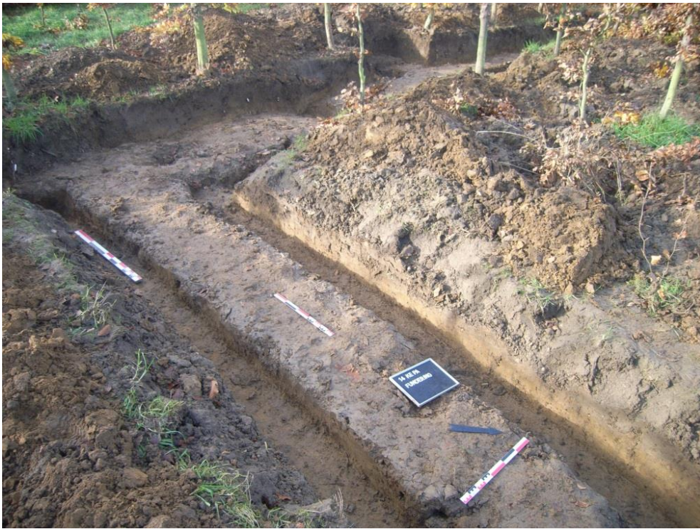
Fig. 11 Zicht vanuit het oosten op de vrijgelegde funderingen.
