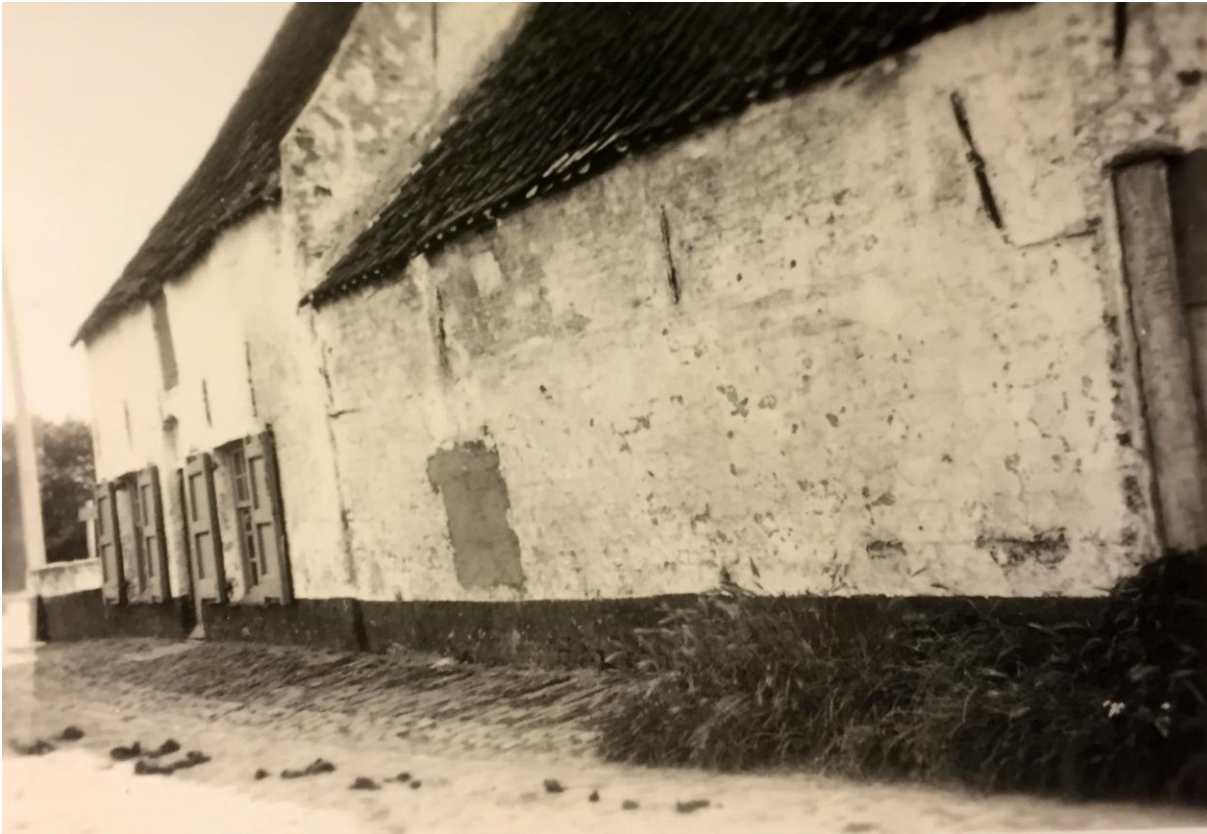
Fig. 29: Foto noordzijde nr. 12, ca. 1930, met de nu verdwenen oude woning/schuur aan de westzijde (Vorselaar, archief familie Soete) waarvan muurrestanten werden aangetroffen. Aan de voorzijde is de gekasseide stoep zichtbaar die vermoedelijk aansluiting vond met het pad van kasseien dat aangesneden werd langs het NO-ZW stuk muur.
