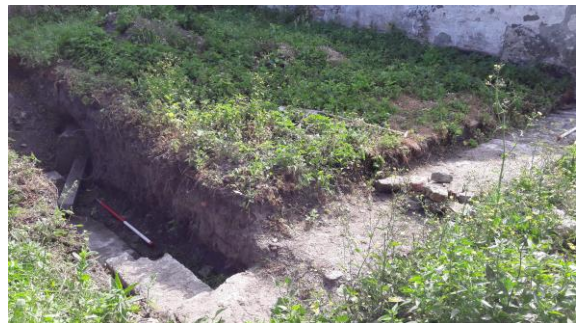
Fig. 12: Een sleufje gemaakt ter voorbereiding van rioleringswerken legt de hoek met en het verdere verloop van het zuid-noord deel van de muur vrij. Zicht vanuit het zuidwesten.
