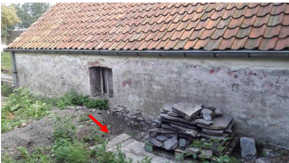
Fig. 16: De drempel, haaks gepositioneerd ten opzichte van de zuidgevel van het bestaande pand. Zicht vanuit het zuidoosten.
