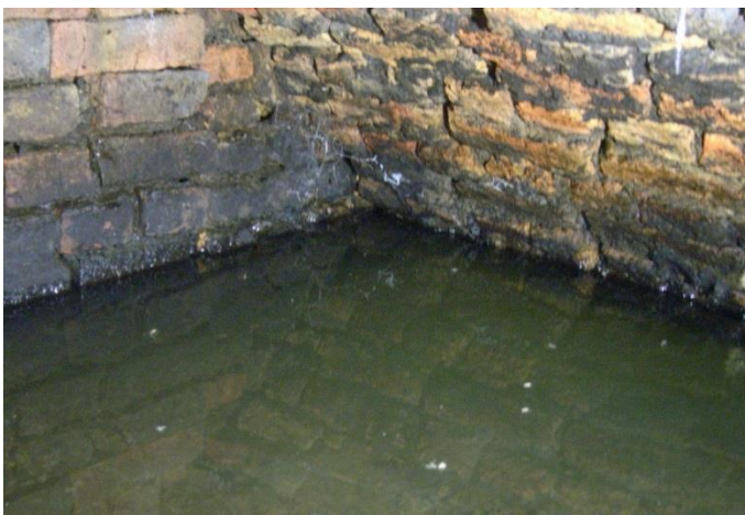
Fig. 23 De zuidwestelijke hoek van de beerput die zich situeert op het naburige perceel.
