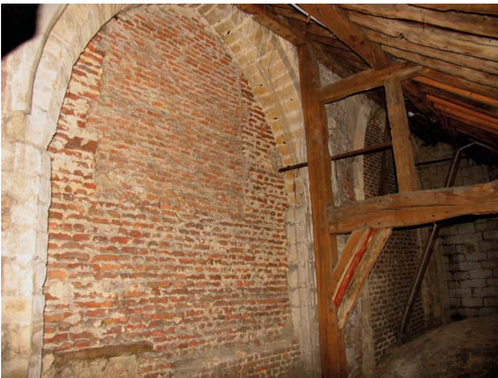
FIG. 4 Voormalig exterieur (zuidkant) van de eerste bouw-fase van het koor, met twee gedichte spitsboogvensters. Tegen de nokstijl van het lessenaarsdak is het fragment van een als korbeel hergebruikte rib uit een houten tongewelf zichtbaar.
