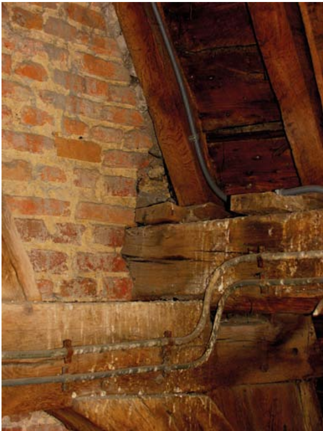
FIG. 11 Fliering van de dakkap van het middenschip, aangebracht in een uitsparing weggehakt in het baksteenmetselwerk van de toren. Roofplate in the roof of the central nave, in a space created by the hacking out of some of the tower's brick masonry.
