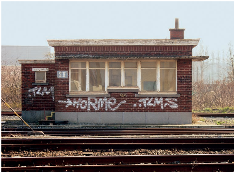
FIG. 4 De Grootte, seinhuis V in Brugge, 1955 (foto Laura May, 25/03/2011). De Grootte, signal box V in Bruges, 1955.
