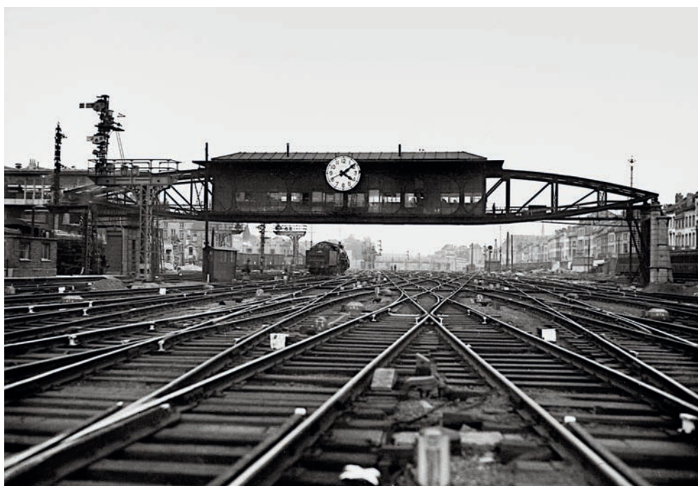
FIG. 7 Seinhuys Brussel-Noord (Brussel, Archiefdienst en Fototheek NMBS-Holding, Z03865, Seinhuys in Brussel-Noord). Signal box at Brussels-North.
