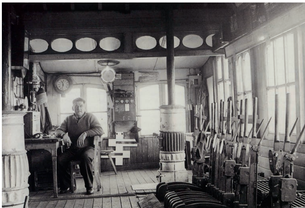
FIG. 1 Interieur van een Saxby-seinhuus (Cresens 2001, 391). Interior of a Saxby signal box.
