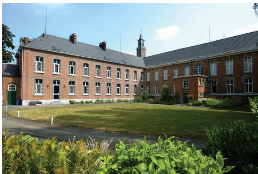
FIG. 5 De westvleugel en de voormalige vleugel van de lekenbroeders, gezien vanuit het zuidwesten. The west wing and the former lay brother's wing, seen from the southwest.
