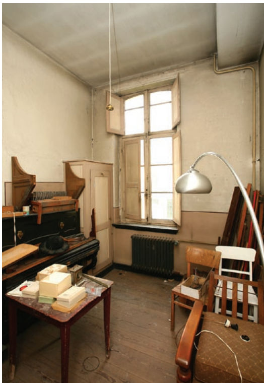
FIG. 25 Zicht op een eenraamsvertrek (185, westvleugel). Op het plafond tekenen zich de rinkellatjes en de kinderbalken af. Interior view of a one-window room (185, west wing). The contours of the laths and the bridging joists are visible on the ceiling.
