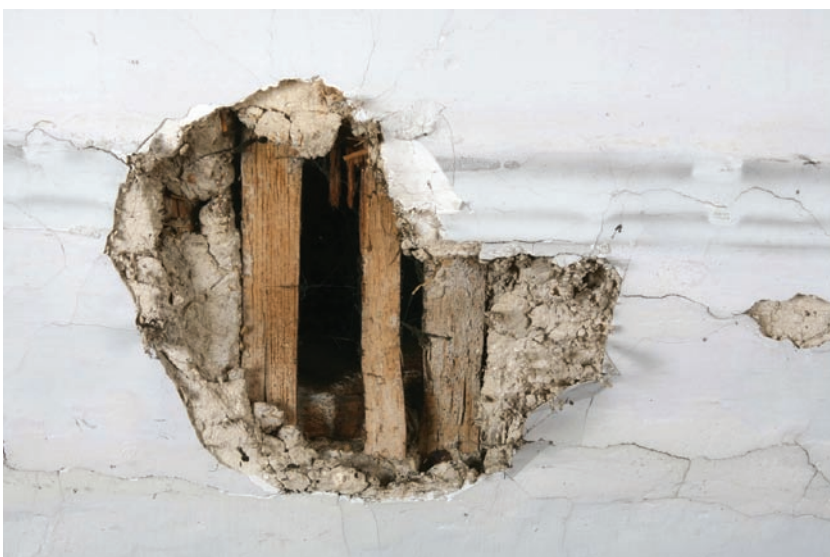
FIG. 24 Plafond van vertrek 144 (oostvleugel). Rinkellatjes gespijkerd op de kinderbalken, vervolgens bepleisterd. Ceiling of room 144 (east wing). Laths nailed on the bridging joists, covered with plaster.
