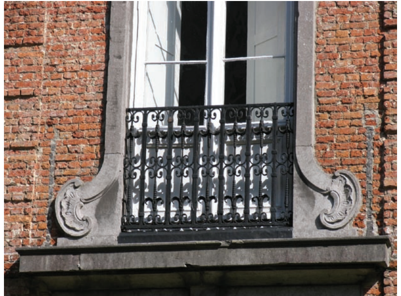
FIG. 14 Zuidvleugel, centraal venster op de eerste verdieping. Links en rechts van de omlijsting zijn zwarte lijnen zichtbaar, sporen van een vroegere, bredere balustrade. South wing, central window on the first floor. Black lines to the left and right of the window frame are traces of an earlier, wider balustrade.
