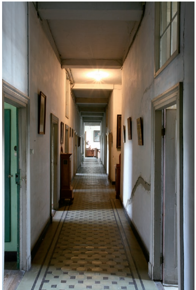
FIG. 20 De middengang van de westvleugel, gezien naar het zuiden. The central hallway of the west wing, looking south.
