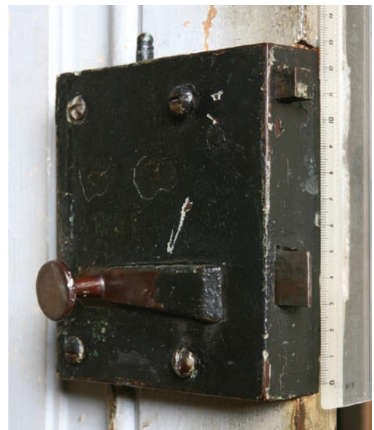
FIG. 35 Oplegslot met bovenaan een knip of nachtschuif, 18de eeuw (vertrek 149, oostvleugel). Applied lock with a catch on top, 18th century (room 149, east wing).
