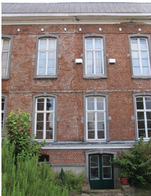
FIG. 11 Bouwnaad in de westgevel van de westvleugel, tussen de tweede en de derde travee (optellend vanaf de voormalige vleugel van de lekenbroeders).
