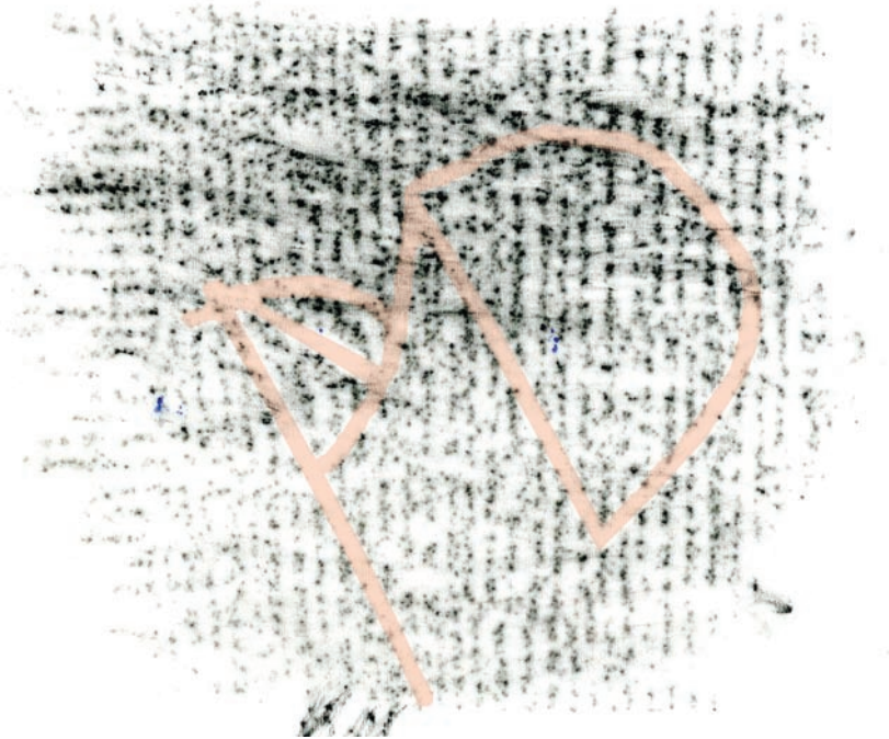
b: Steenhouwersmerk P M D. Vertrek 159 (zuidvleugel, eerste verdieping), linkerkenster, rechterdagkant. Stonemason's mark P M D. Room 159 (south wing, first floor), left window, right jamb.
