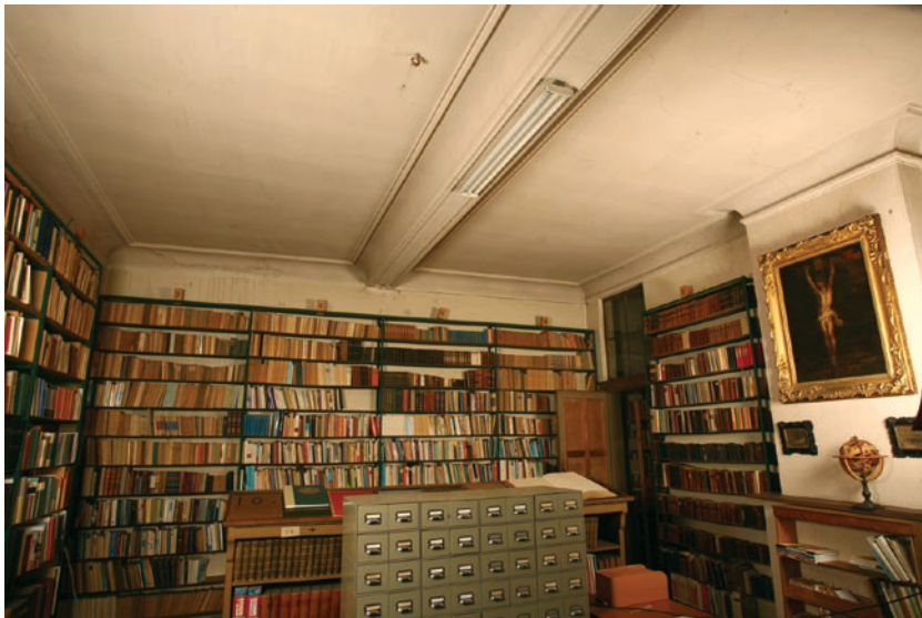
FIG. 27 Binnenaanzicht van vertrek 136 (oostvleugel). Het plafond is versierd met een kooflijst afgeboord door gestuukte profielen. Ook de moerbalken zijn versierd met gestuukte profielen. Rechts is de schouw zichtbaar.
