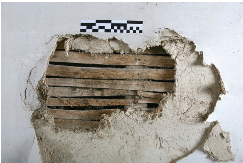
FIG. 23 Oostwand van de middengang ter hoogte van de vertrekken 127-128 (oostvleugel). Stijl- en regelwerk waarop rinkellatjes zijn gespijkerd, vervolgens bepleisterd. Eastern wall of the central hallway near rooms 127-128 (east wing). Laths nailed on the framed wall, covered with plaster.
