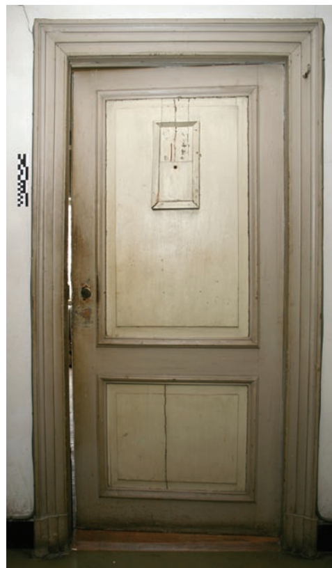
FIG. 33 Deur van het vertrek 156 (zuidvleugel), gezien vanuit de middengang. Door of room 156 (south wing), as seen from the central hallway.
