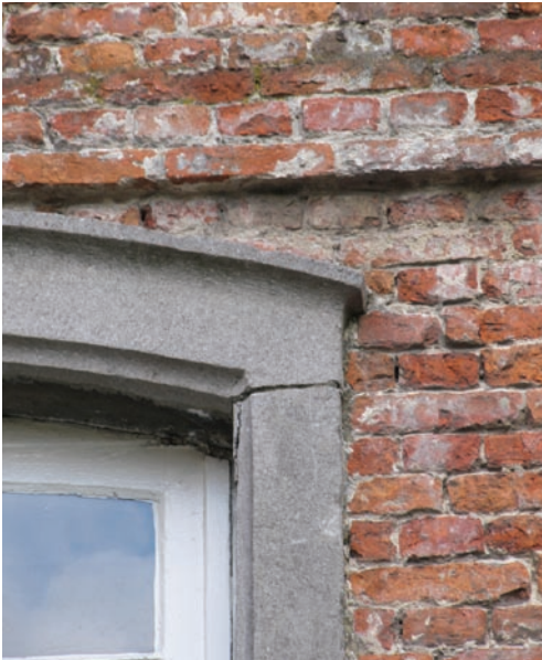
FIG. 13 Hardstenen vensterlijst, links van de bouwnaad in de westvleugel. Zonder blokvorm op de hoek van de segmentboog. Blue limestone window frame to the left of the building joint in the west wing, without the block of the segmental arch.
