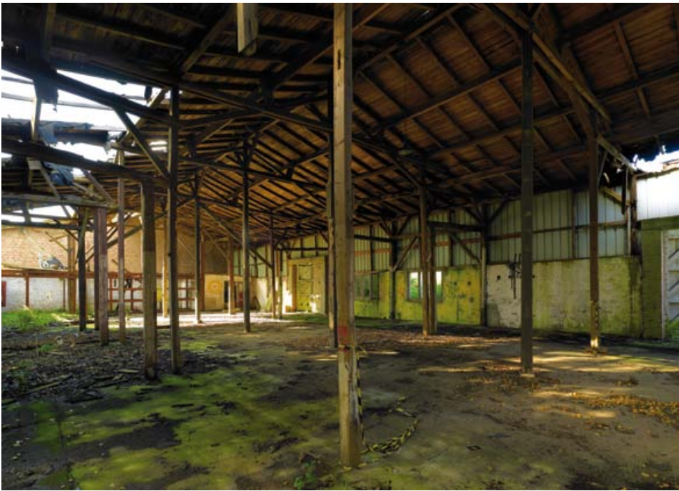
FIG. 15 Foto van het interieur van de grote barak. Photo of the interior of the larger barrack hut.
