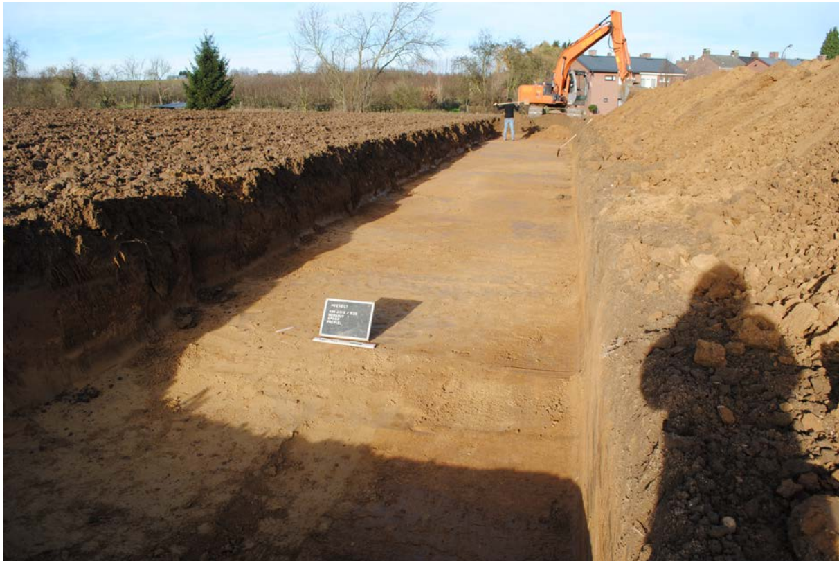
Fig. 2.1: Aanleg van het vlak.
