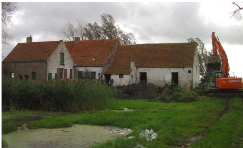
Figuur 1: Aanleg van sleuf 1 langsheen het beschermde woonvolume
