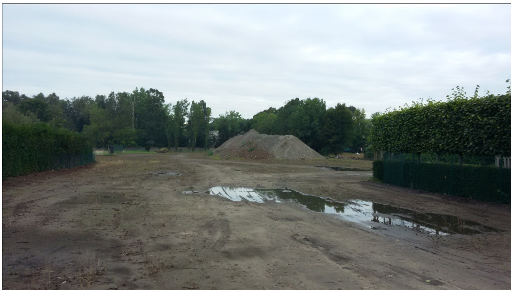
Figuur 3. Het projectgebied gezien vanuit de Elsбургstraat met rechts de puinberg.
