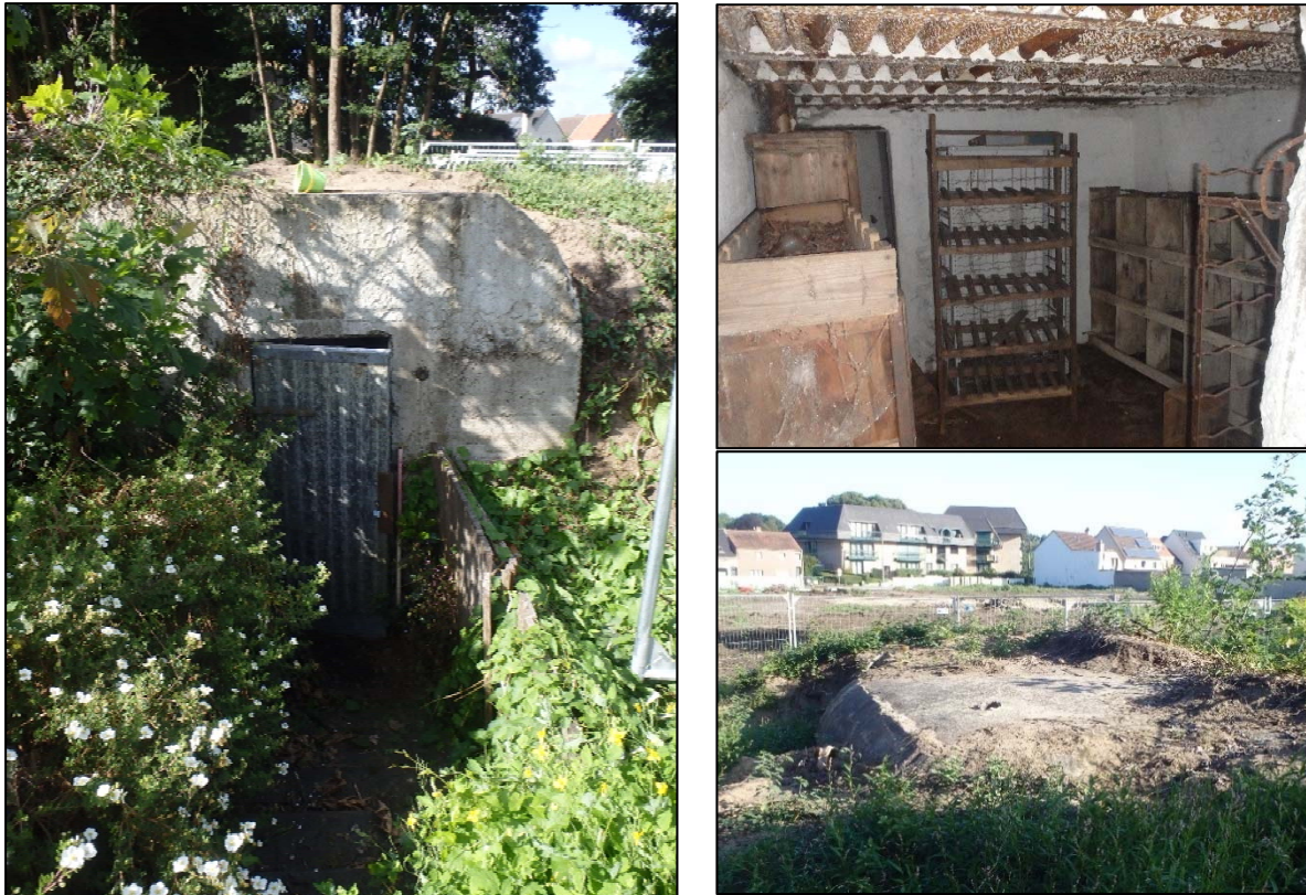
Figuur 29: Zicht op de trap en deur (links), binnenkant (rechtsboven) en bovenaanzicht (rechtsonder) van de bunker
