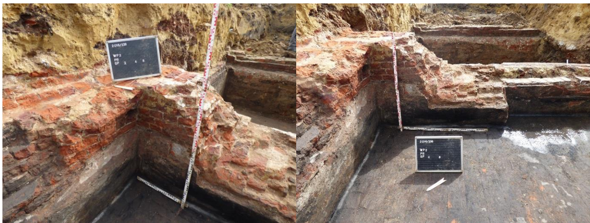
Fig. 4.8: (Links) de bouwnaad van S4 met aansluiting aan S2 en (rechts) een overzichtsfoto van S4.
