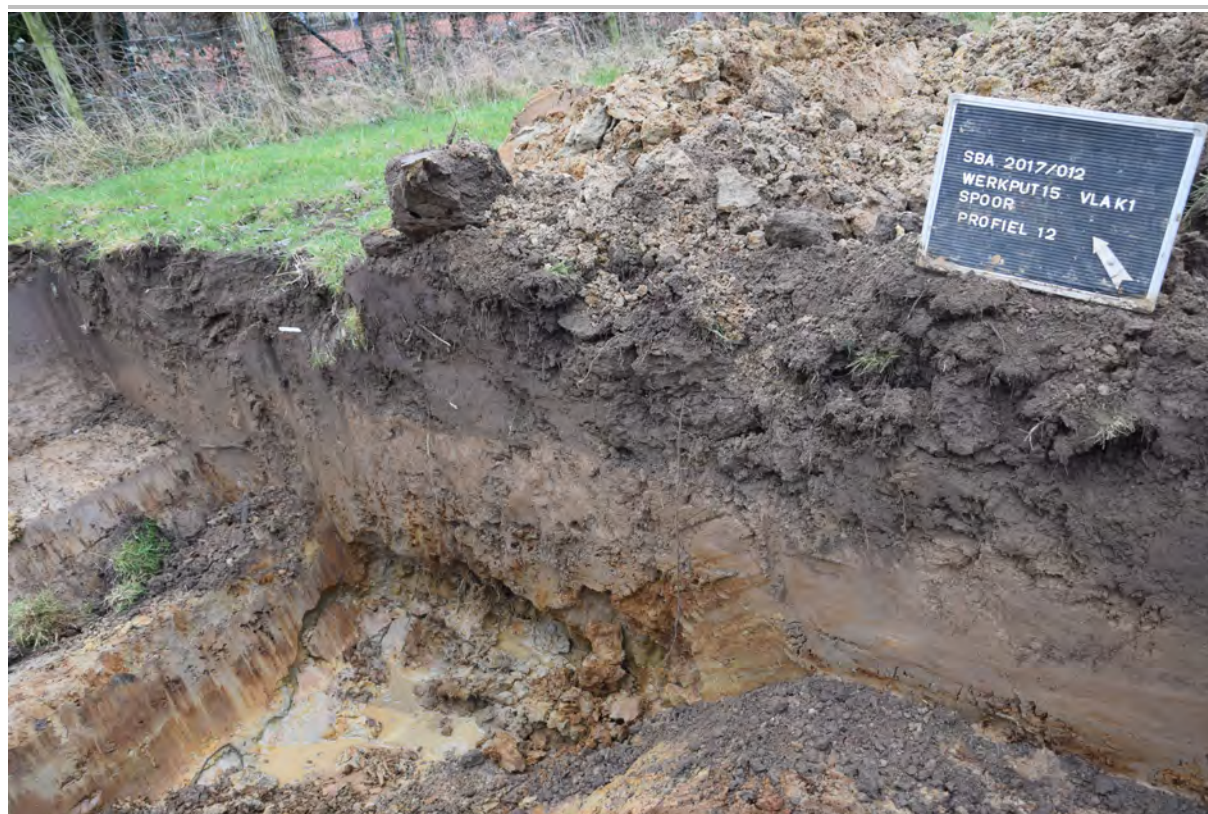
Fig. 3.9: Zicht op het ingekalfde profiel 12.
