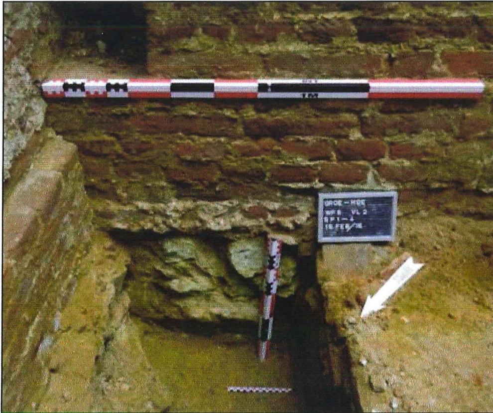
Figuur 87: Fundering van de zuidelijk zijgevel (ABO NV)
