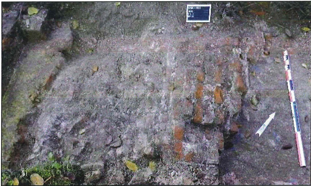
Figuur 32: gedeelte van de omgevallen muur spoor 16 (ABO NV)
