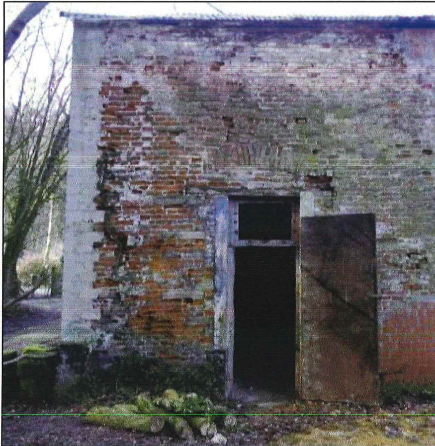
Figuur 71: Zuidelijke hoek oostgevel met relict afbraak koorpartij (ABO NV)
