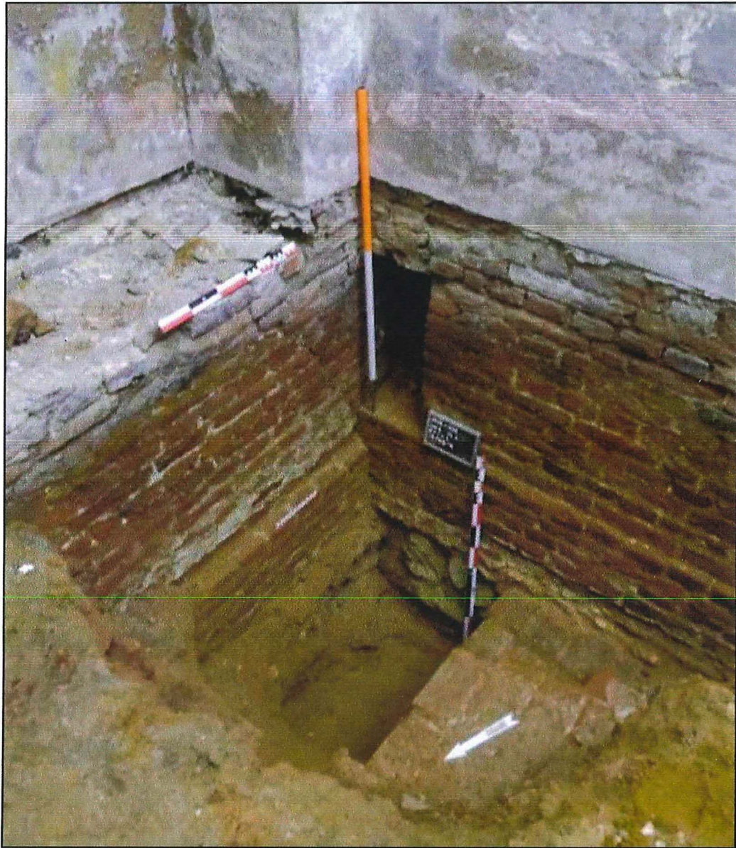
Figuur 85: Algemeen zicht op werkput 8 (ABO NV)
