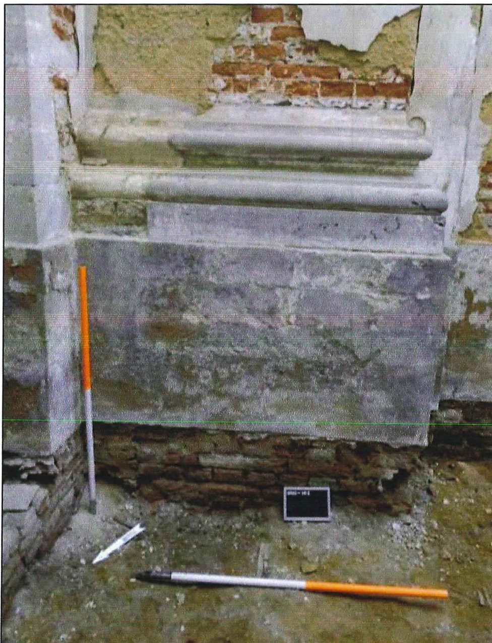
Figuur 89: Vooraanzicht pilaster met duidelijke aanpassing van de profilering (ABO NV)
