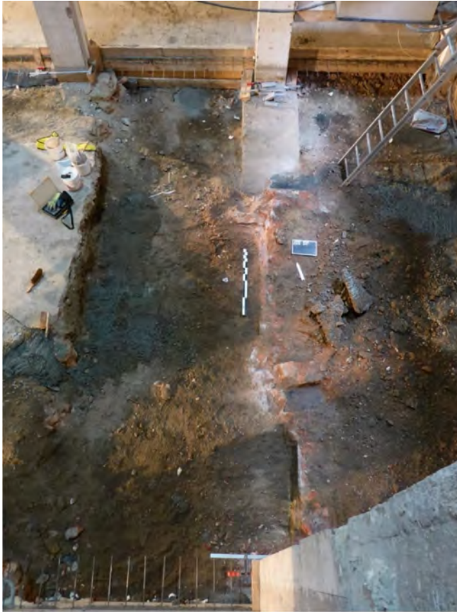
Fig. 47 en 48: een fundering uit de renovatiefase van de jaren 1950 (muurwerk is gewapend met betonijzer en rust bovenop de betonnen pijlers van het gebouw) in de uitgegraven liftkoker in de kelder van de Gildekamersstraat 6.
