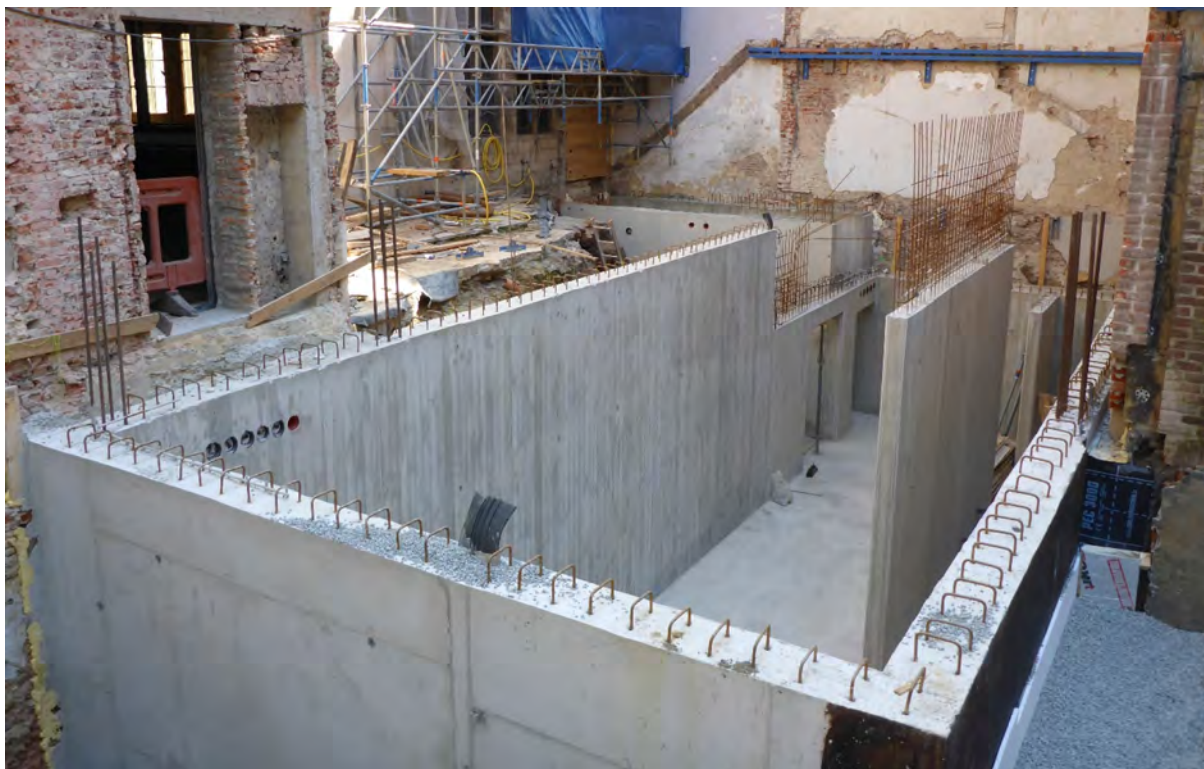
Fig. 43: intussen is de nieuwe kelder al grotendeels opgetrokken. Het op te graven volume bevindt zich tussen de achtergevel en de betonnen kelderwand.
