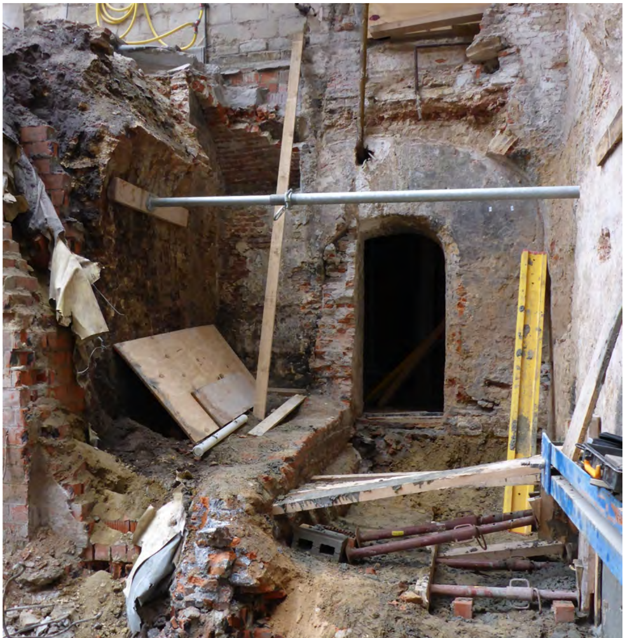
Fig. 59: foto van kelder 1: spoor 001 is de muur met aanzet tongewelf links in beeld, spoor 005 de muur met de deuropening en spoor 036-038 de gemeenschappelijke muur rechts in beeld. In de deuropening is te zien hoe de reeds afgebroken muur uit 1879 de kelder in twee heeft gedeeld.
