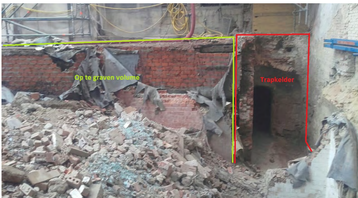
Fig. 32: een bouwput vol puin na afbraak van de kelder uit 1980. Het op te graven volume wordt bijeengehouden door schoringmuren uit 1980. De trapkelder rechts in beeld is deels afgebroken: de trap is reeds gesloopt, maar de linkse kelder muur moet nog worden afgebroken (foto eigendom van Nick Ghijs).
