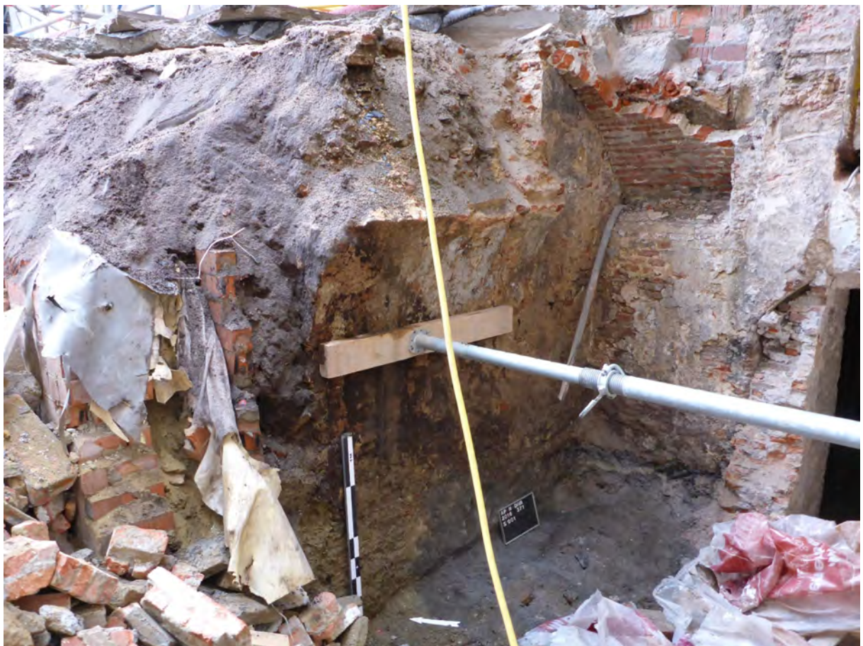
Fig. 34: extra schoorwerken ter consolidatie van de oude keldermuur (spoor 001).
