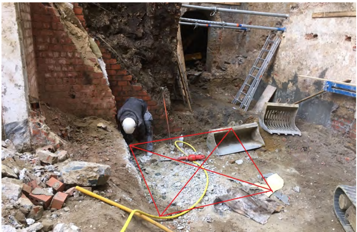
Fig. 40: locatie waar er uitzonderlijk 1,4 m dieper gegraven wordt voor de aanleg van een liftkoker (foto eigendom van Nick Ghijss).
