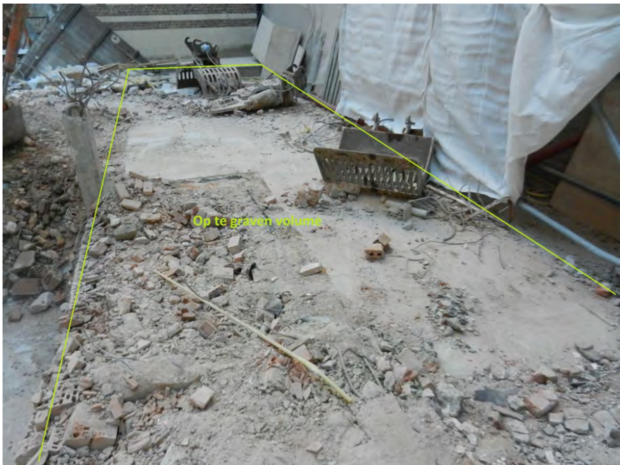
Fig. 30: zicht op de noordelijke helft van het op te graven volume.
