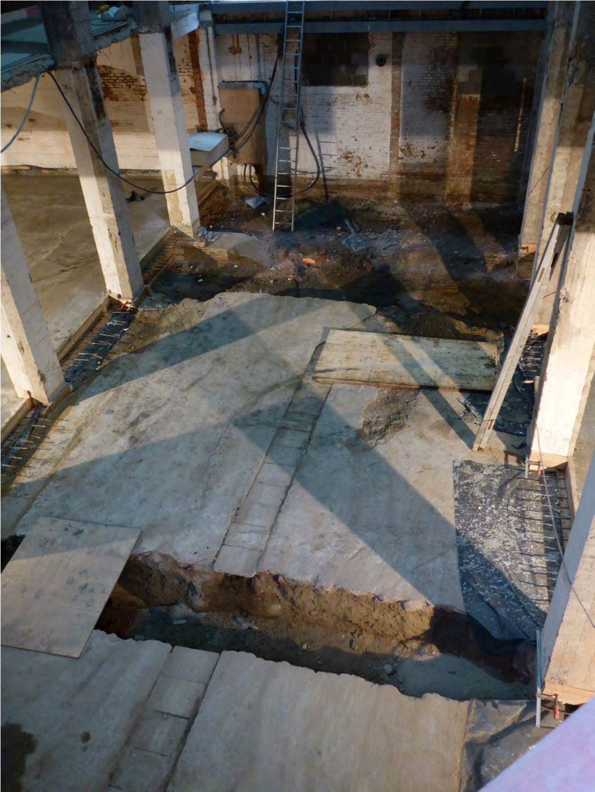
Fig. 46: werkput 2: overzicht van de uitgegraven volumes in de kelder van de Gildekamersstraat 6. Bovenaan in beeld de bouwput van de liftkoker en onderaan de sleuf voor de betonmuur. De vloer bestaat uit baksteen met een dikke cementlaag en wordt doorkruist door drie rioleringsgootjes.
