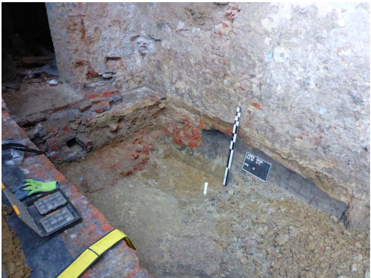
Fig. 20: profiel 006: gemeenschappelijke kelder muur, met eronder middeleeuwse funderingsresten in opmaakzand, bovenop zandige moederbodem.
