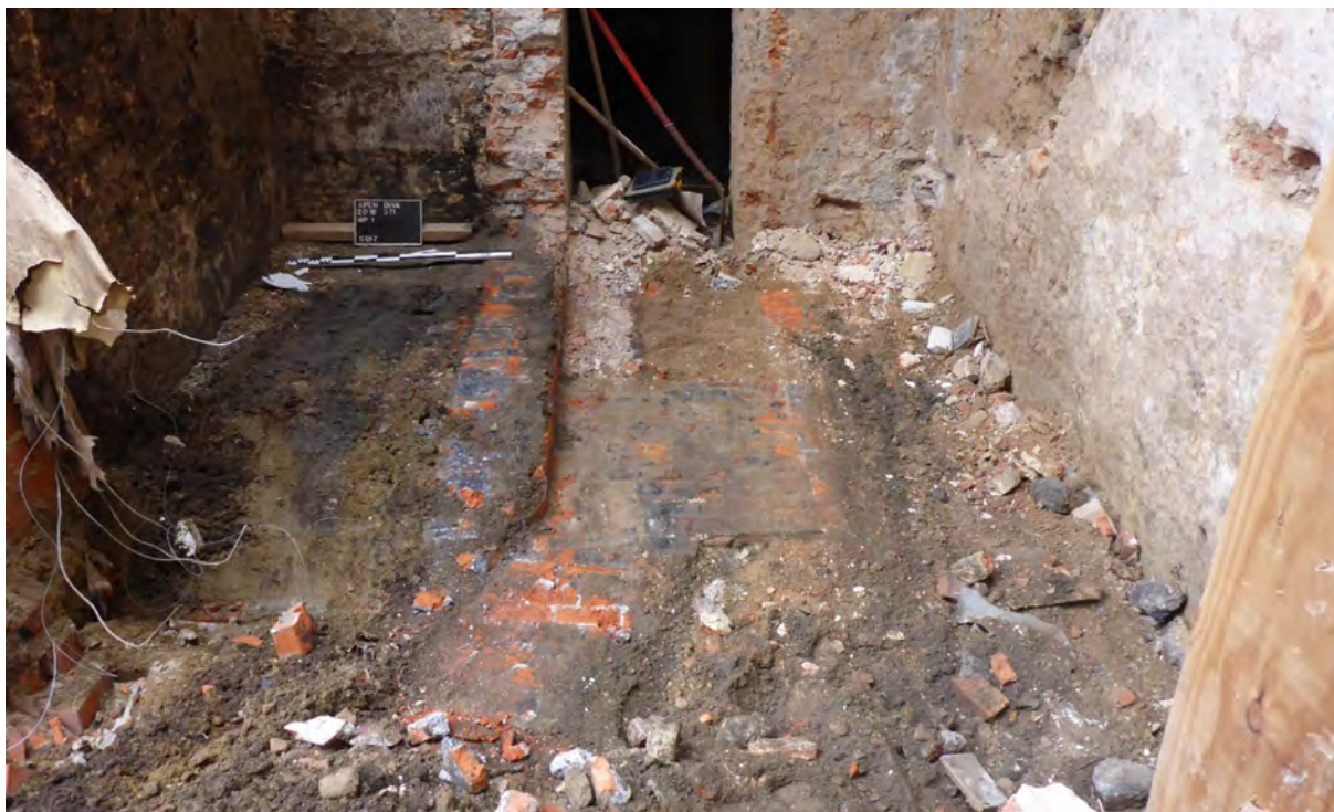
Fig. 79: keldermuur 018 en keldervloer 021 (vlak 3).
