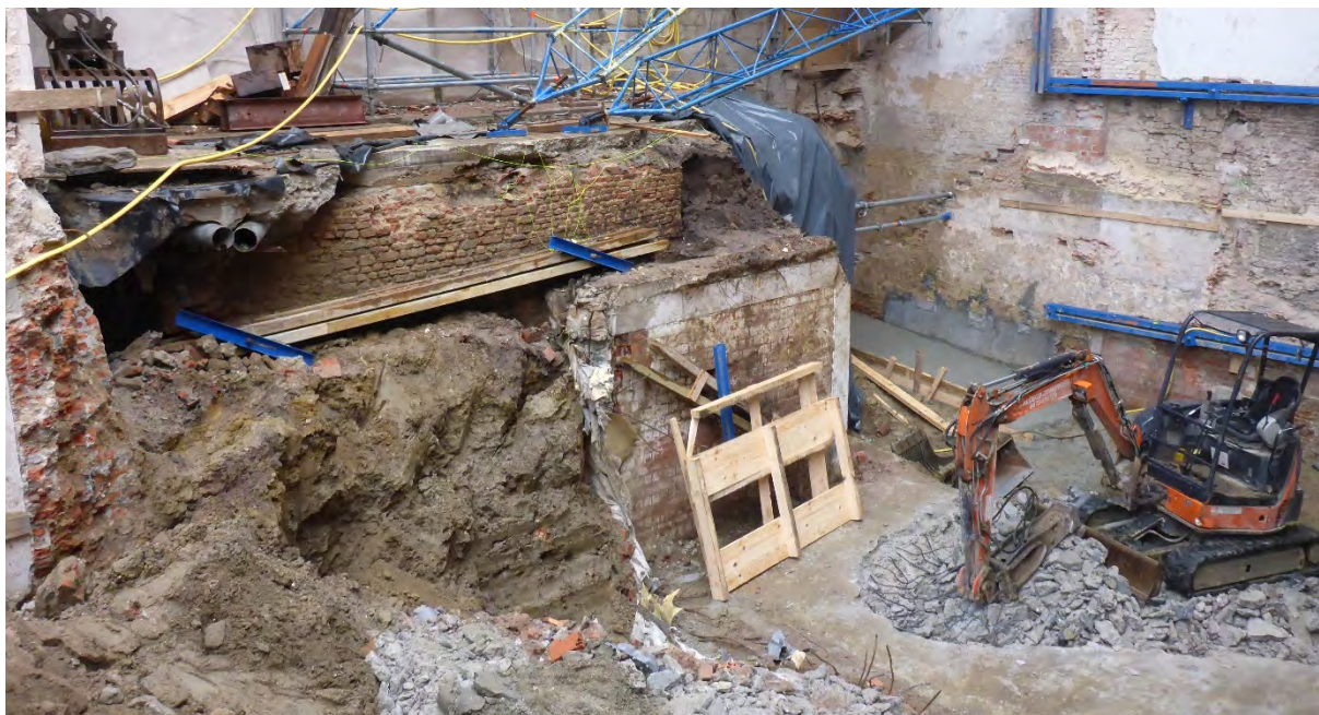
Fig. 37: de oude keldermuur (spoor 002) komt vrij na het uitgraven van het puin dat van de afbraak van de recente kelder komt. Deze kelder wordt bijeengehouden door schoringsmuren uit de jaren 1980 en tijdens het onderzoek aangebrachte poutrellen. Op deze foto is men nog de betonnen keldervloer aan het piqueren. In de achtergrond is het grondvlak uit Fig. 35 en 36 reeds gebetonneerd.
