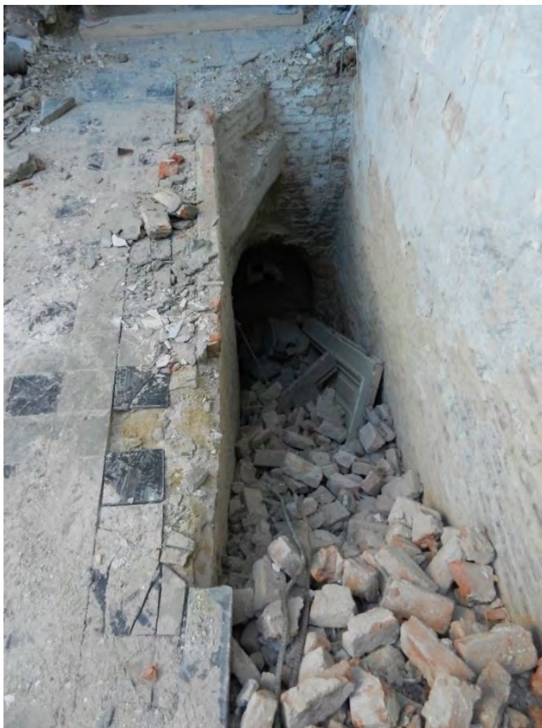
Fig. 31: de te slopen trapkelder uit 1879, vol puin afkomstig van de sloop van het opgaand muurwerk van deze achterbouw.
