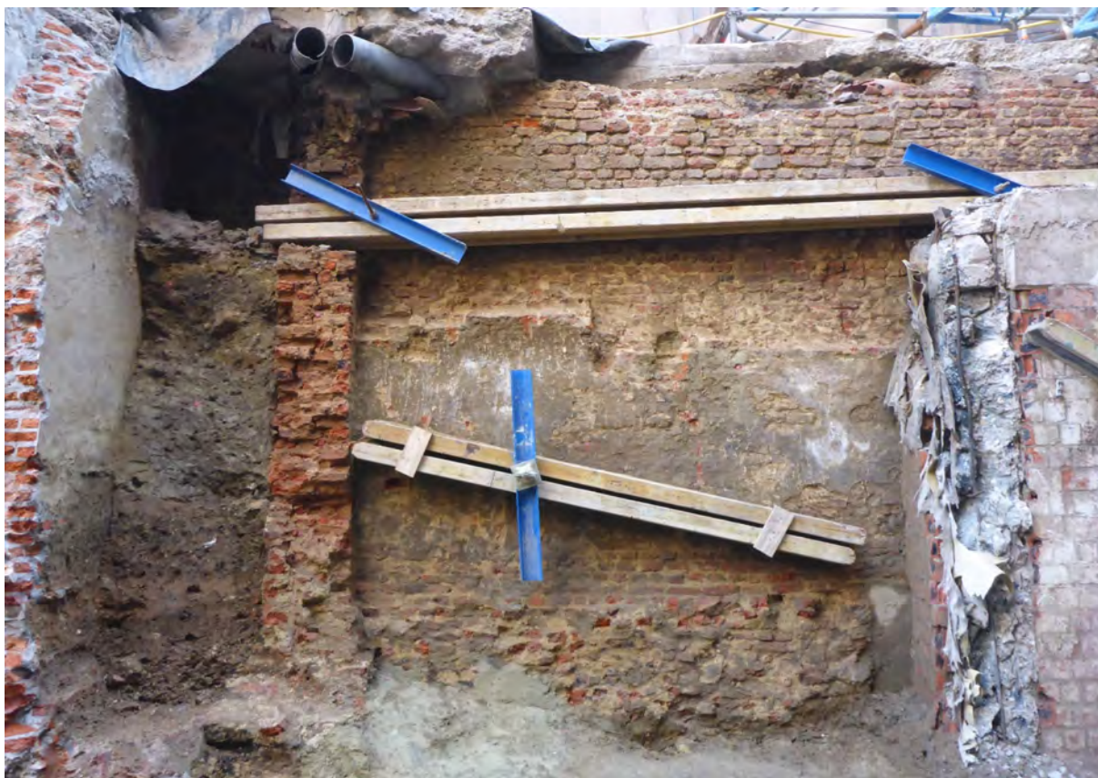
Fig. 38: na volledig afgraven van het bouwpuin is de oude keldermuur (spoor 002) helemaal bloot komen te liggen.
