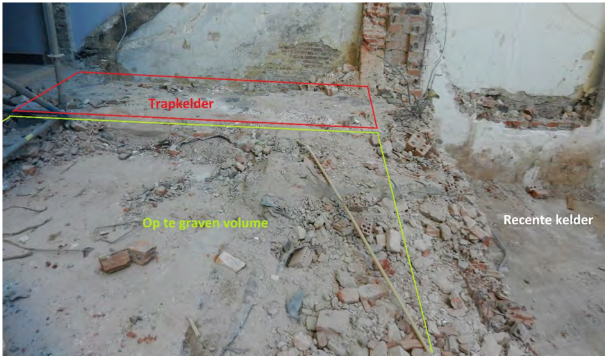
Fig. 29: zicht op werkput 1 na de sloop van een traphal en de nog te slopen trapkelder uit 1879, de zuidelijke helft van het op te graven volume en het nog uit te breken kelderplafond rechts in beeld.
