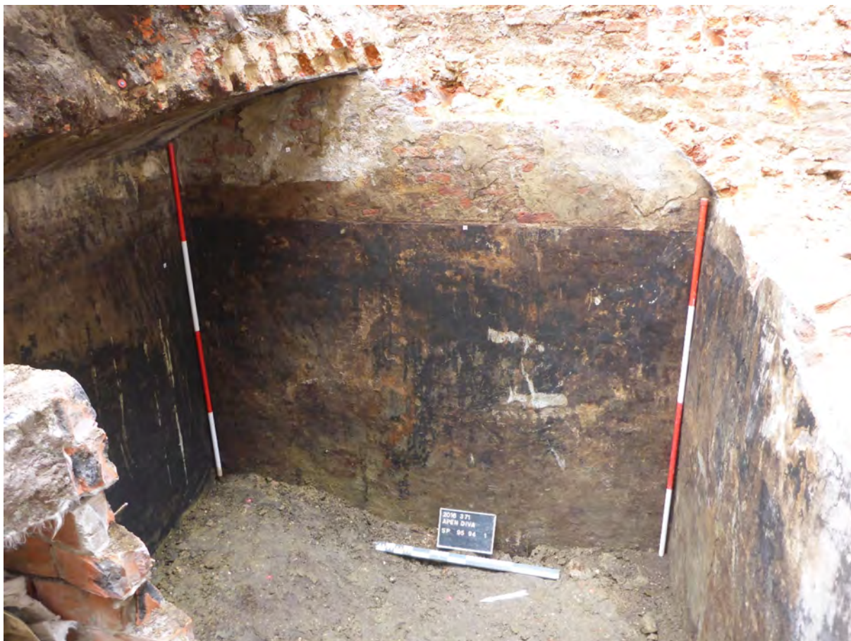
Fig. 45: de keldermuren na verwijderen van de stortlagen, tot op het niveau van de verstoring (vloer van de kelder werd niet bereikt).
