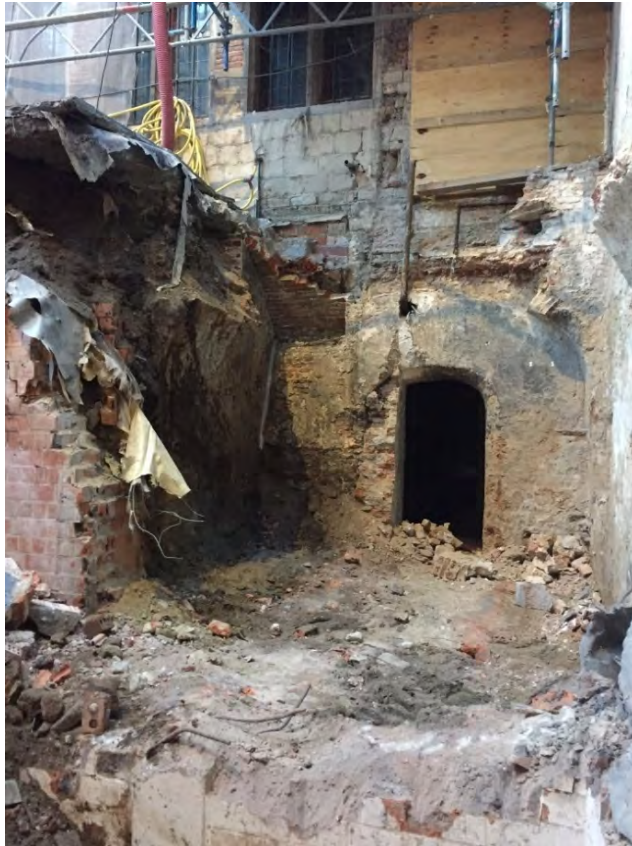
Fig. 33: resultaat na de volledige ontmanteling van de trapkelder uit 1879: de oude kelder, met aanzet tongewelf is nu zichtbaar. Het gedeelte rechts van de kelderdeur is reeds eerder bouwhistorisch onderzocht (Maclot 2015 en Deceuninck 2016), het recentelijk aan het licht gekomen deel links (spoor 001) is door GATE fotogrammetrisch vastgelegd (foto eigendom van Nick Ghijss).
