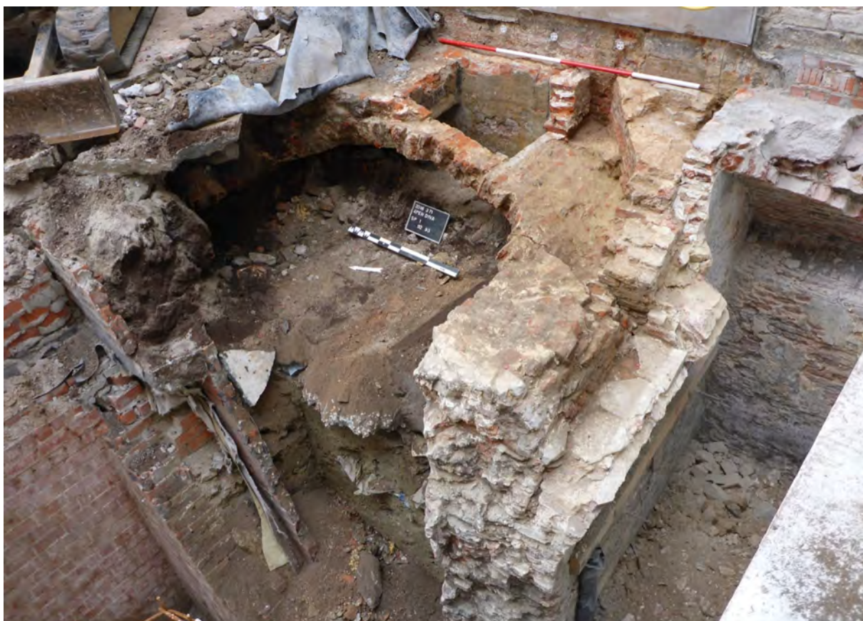
Fig. 67 en 68: foto van kelder twee met tongewelf, stortgat en een vulling die volledig bestaat uit recente stortlagen met afbraakmateriaal en afval van de bouwphase uit de jaren 1980.
