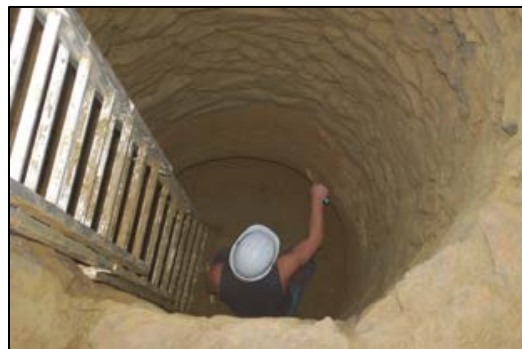
FIG. 15 Het opschonen van de waterputschacht.
