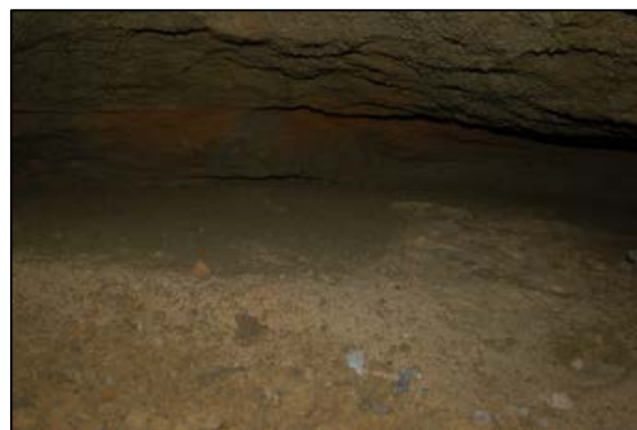
FIG. 21 De holte gevormd door het wegspoelen van het zand.
