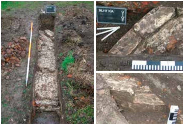
Fig. 12: zicht op de zuidoosttoren van het kasteel in sondering 3 en detailopnames van het metselwerk
