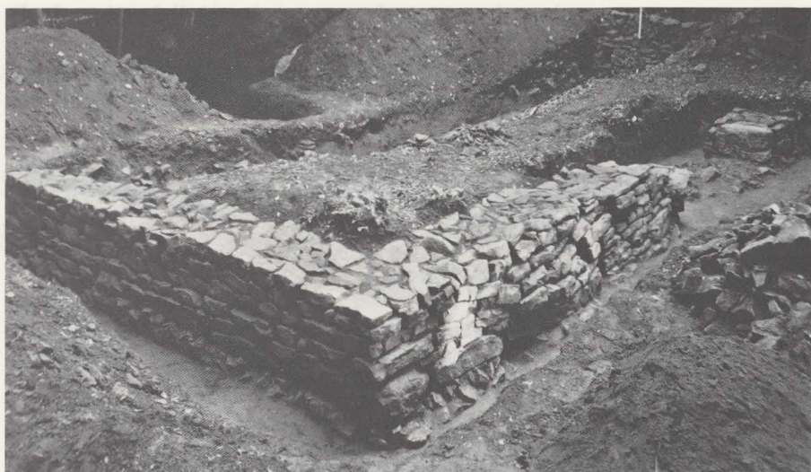
4 Le bâtiment B.
