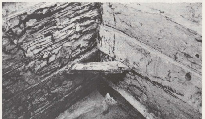
6 Schuin dwarsbalkje in de noordwestelijk hoek.
