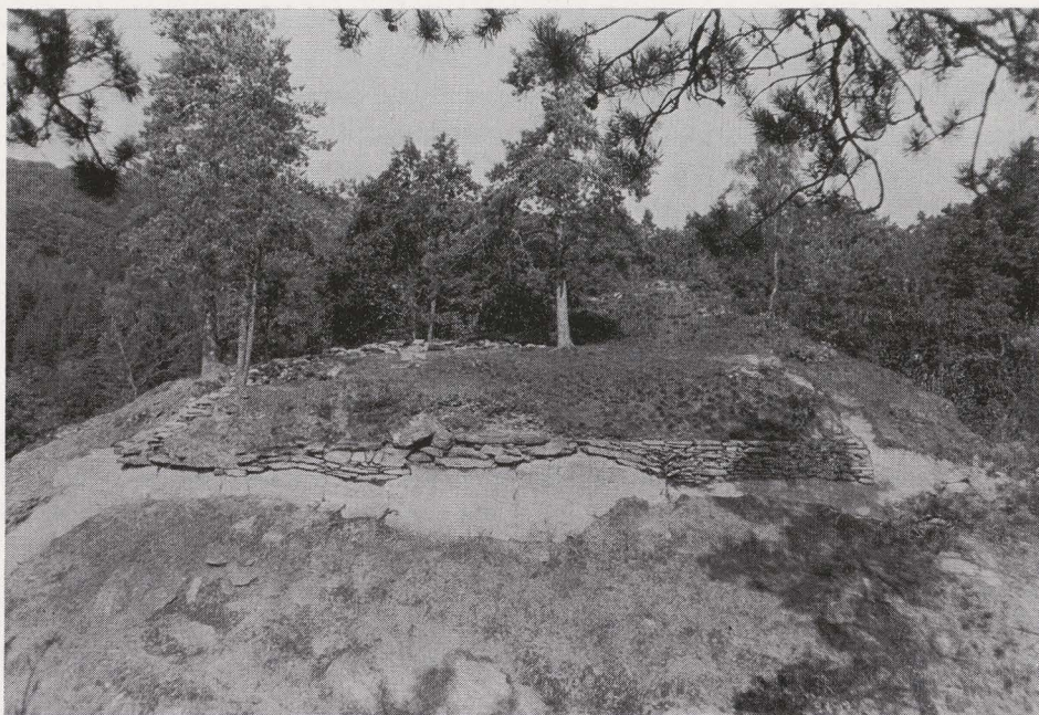
Fig. 10. — Le donjon, au sommet de l'ouvrage.
