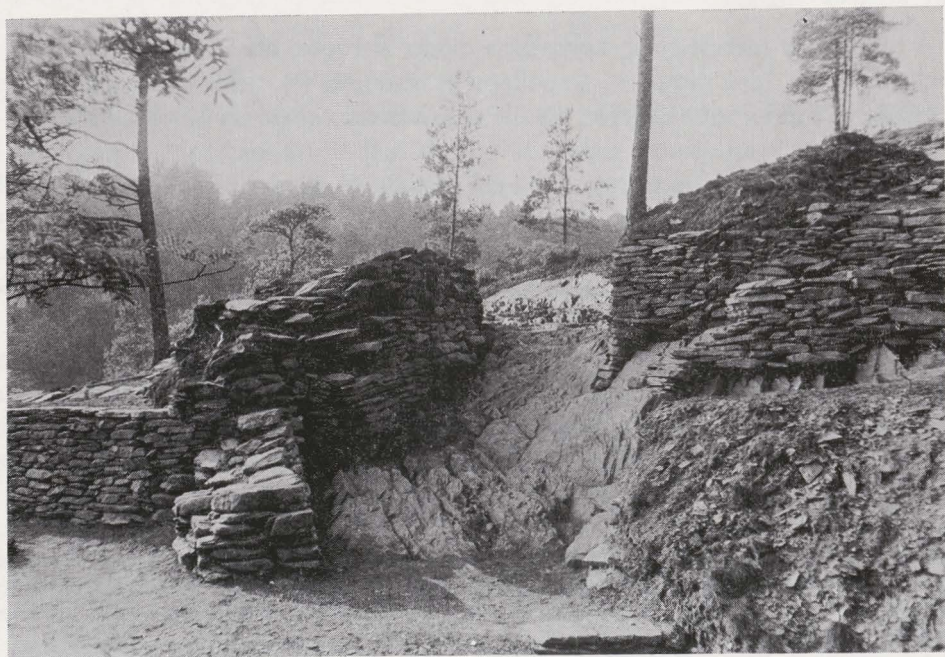
Fig. 4. — Le complexe d'entrée.
