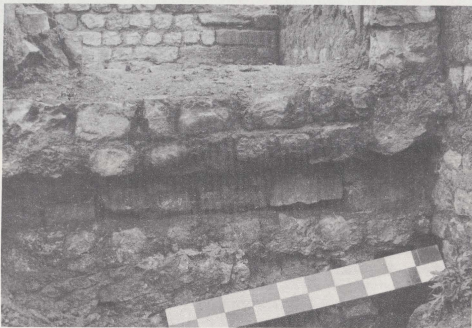
Vue d'une porte d'accès aux bains-publics présentant trois remaniements successifs
