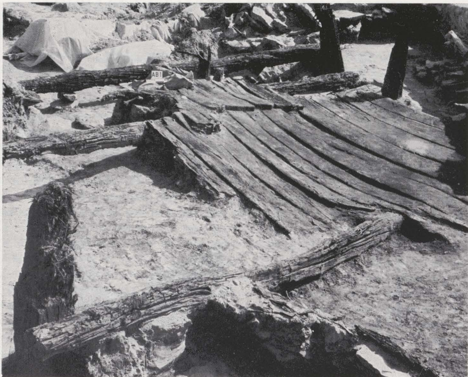
Fig. 36. — Vue partielle du débarcadère.
