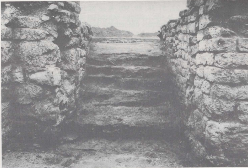
FIG. 5. — L'escalier reliant la pièce A à la cave B.
