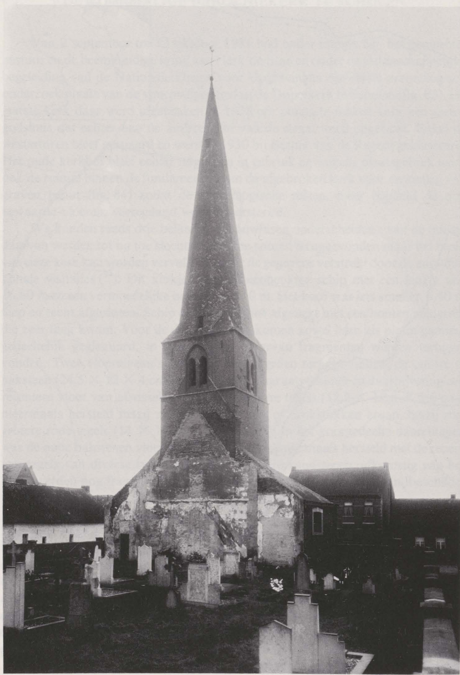
Fig. 84. De toestand van het terrein in 1949, gezien vanuit het N.-O. (© ACL, Brussel).
