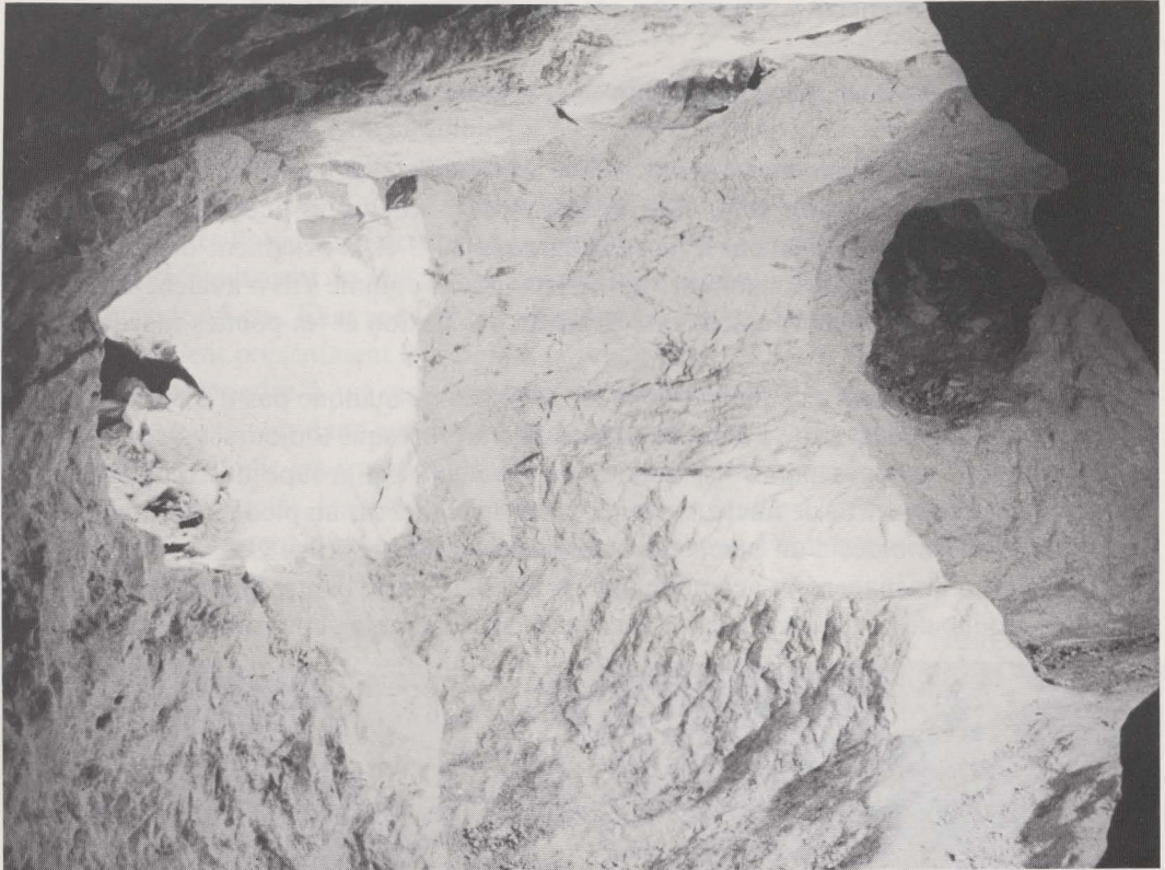
Fig. 8. Muret de craie séparant deux chantiers avec soupiraux.
