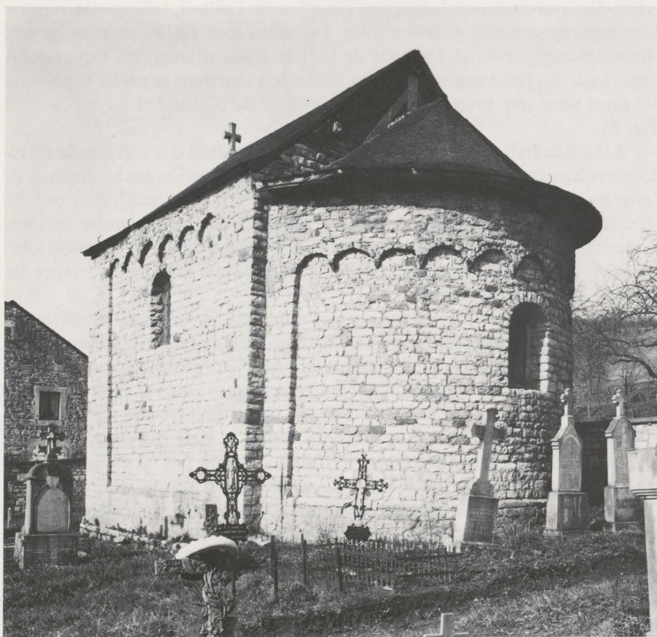
Fig. 1. Le chevet de l'ancienne église romane, avant sa restauration. Façade sud-est. © A.C.L.
