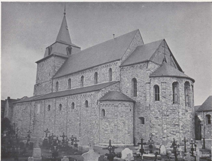
Pl. X b. — Vue générale de l'église après la restauration.
