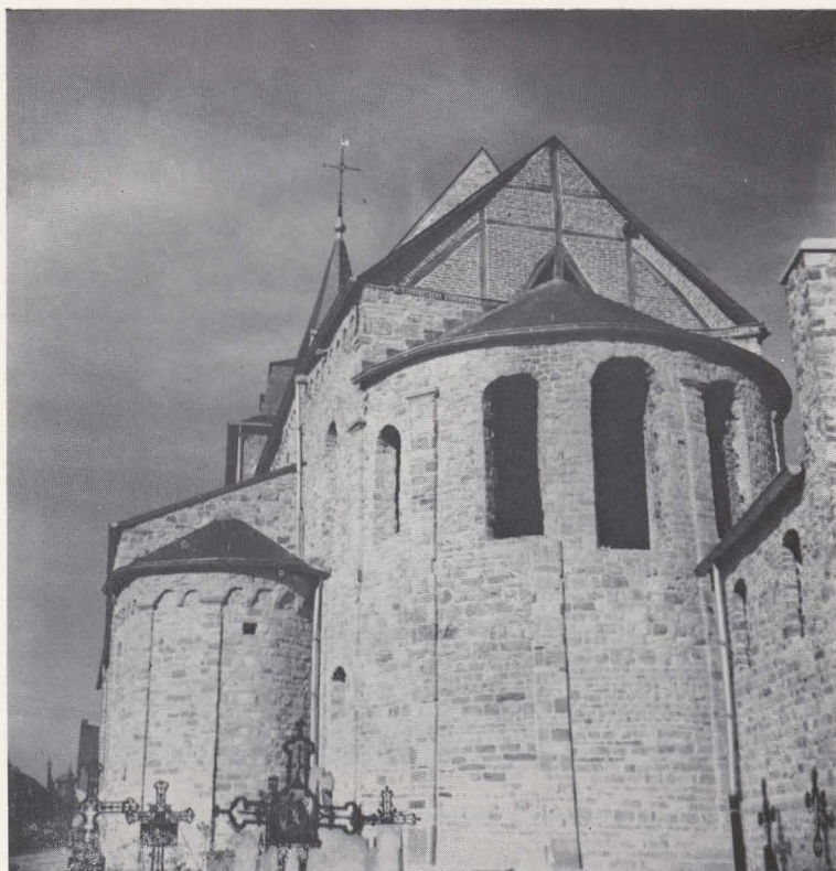
PL. III b. — Vue de l'extérieur du chevet roman après la restauration.
