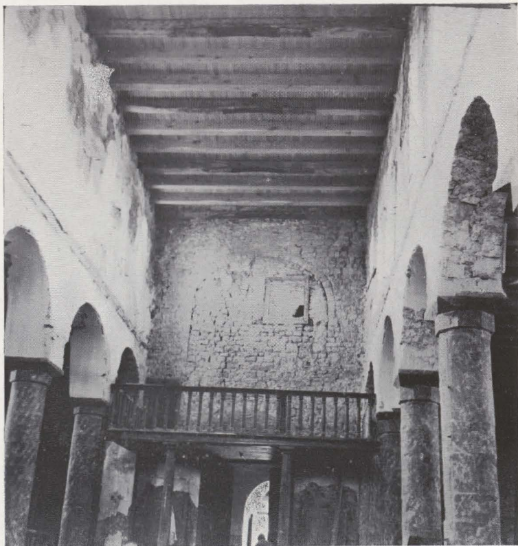
PL. VII. — Intérieur de l'église pendant la restauration. Vue vers l'ouest.
