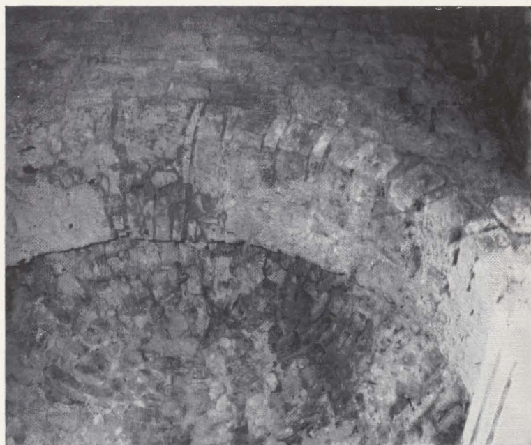
PL. IV b. — Arc en opus mixtum couvrant l'entrée de l'absidiole nord.
