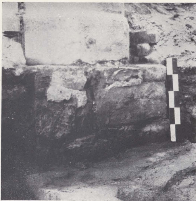
PL. IXa. — Pilier de la nef avec base carrée primitive.
