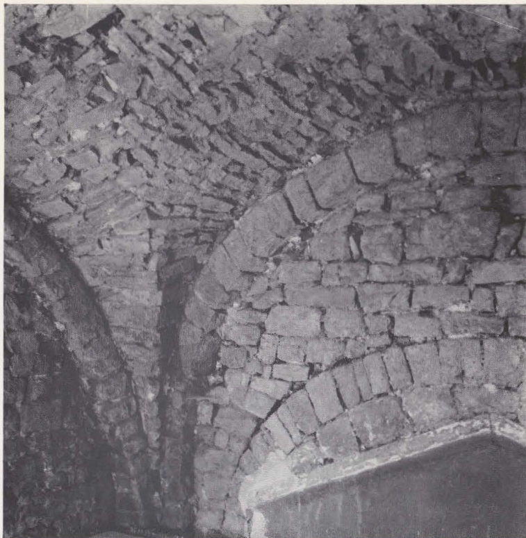
PL. VI a. — Voûte du porche roman.
