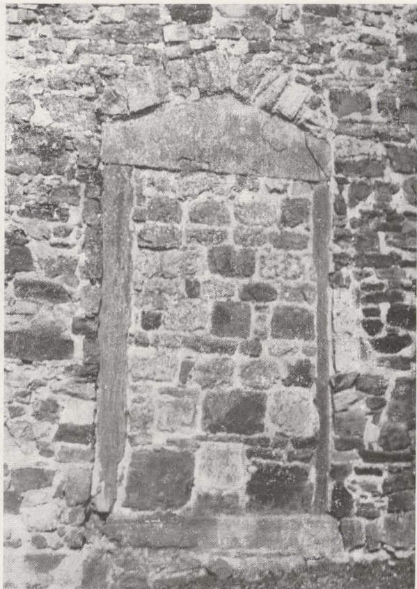
Pl. V a. — Porte murée, dans le bas-côté nord.
