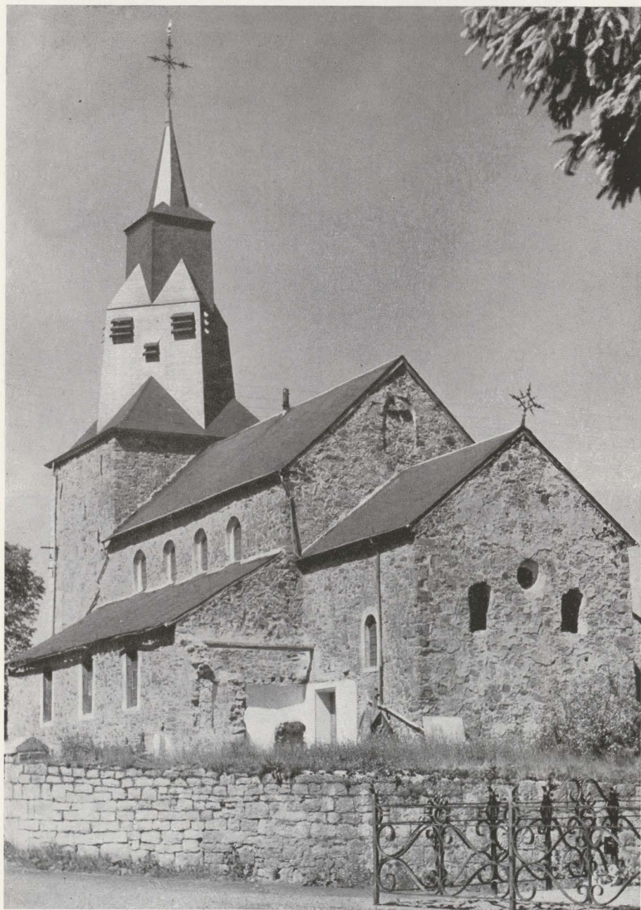
Pl. I. — L'église vue du sud-est, pendant les travaux de restauration.
