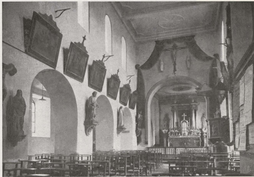
Pl. IX b. — Intérieur de l'église avant la restauration.
