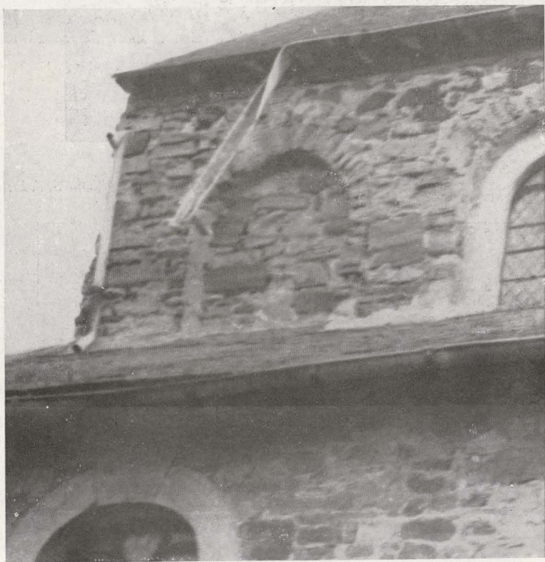
Pl. VI b. — Arcade dans la face nord de la nef centrale.
