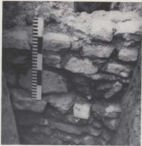
AFB. 13. — Detail van muur 6.
