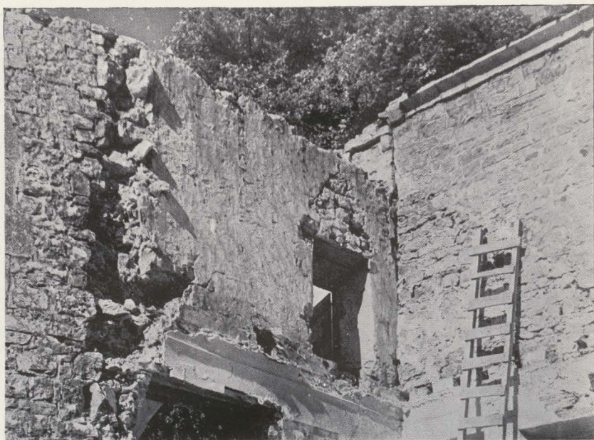
2. Sacristie et chapelle latérale pendant la restauration.
