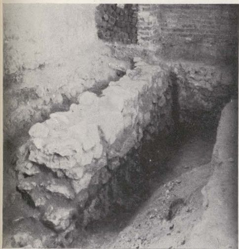
1. Murs dans la partie occidentale de l'église.
