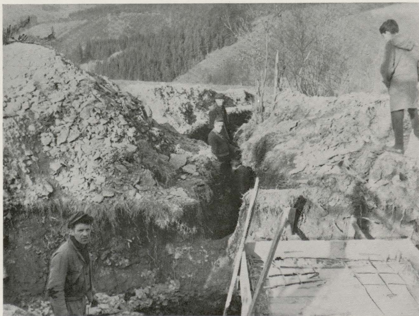
PLANCHE IV, b. — Etat des travaux au moment de la découverte. La tranchée venant du sud aboutit à la chambre-déversoir en construction, à l'avant plan. (Photogr. A. G.)
