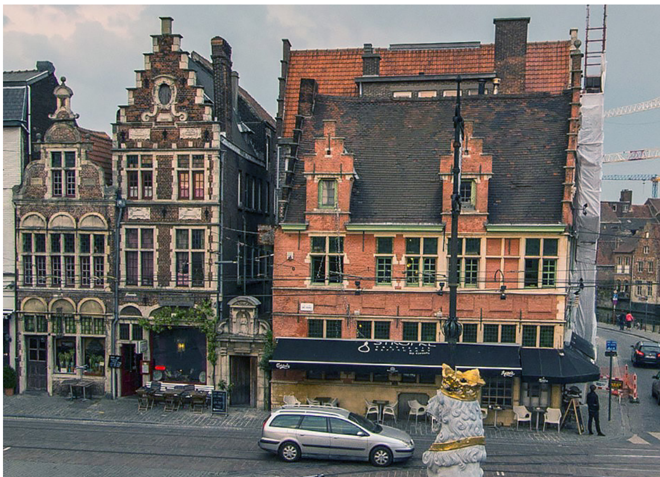
FIG 4 De gevelluifel bij dit pand verstoort de leesbaarheid van de gevel. De ramen op het gelijkvloers worden doormidden gesneden. / FOTO: Geldmunt Gent COPYRIGHT: Onroerend Erfgoed
