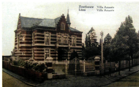
◀ De villa en het park van de Corswarem in de jaren 1920 (collectie José Huyppens, Dormaal-Zoutleeuw)
