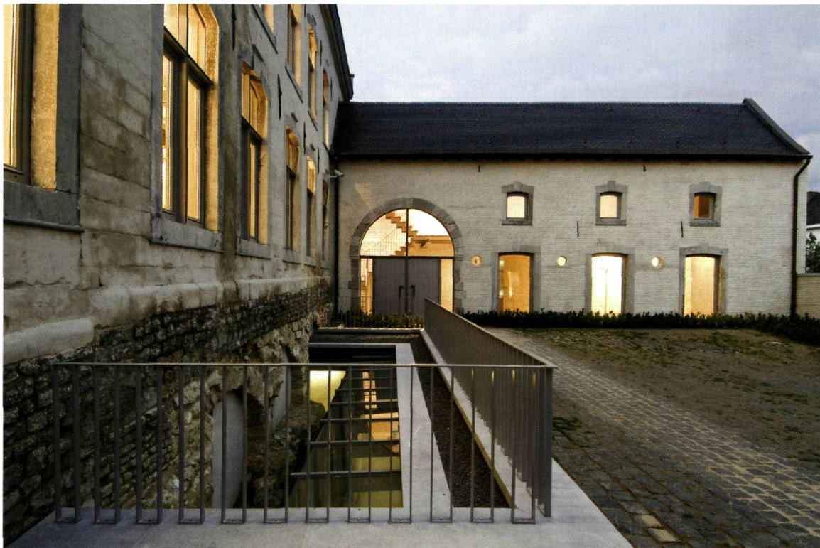
◀ Het Agnetenklooster in Tongeren, zicht op de zuidvleugel en de middenvleugel (Foto Architectenbureau Michel Janssen)
