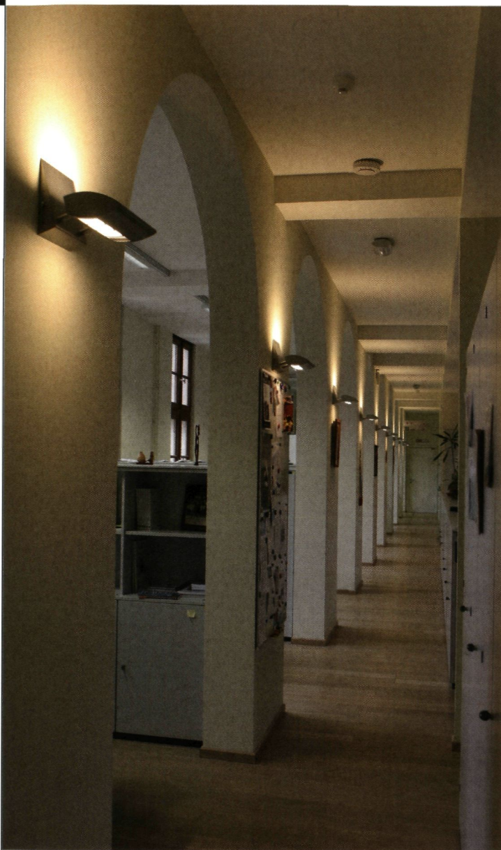
▲ Kantoren ondergebracht in de vroegere slaapcellen, waarvan één wand werd opengewerkt. (Bron: fototheek van het ITG)
