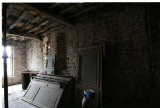
◀ Enkele oude rondboogramen zijn nog zichtbaar
