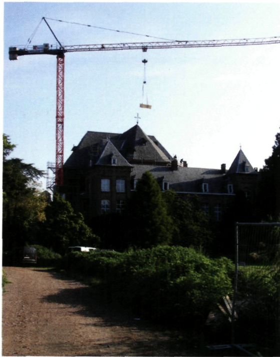
► De voormalige jezuïetenresidentie, zicht vanuit de tuin (Foto Veerle De Houwer)
