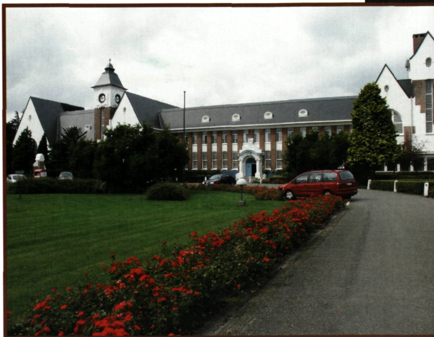
▲ Het Bethaniënhuis in Zoersel, toestand vóór de werken, met oorspronkelijk schrijnwerk (Copyright Nerufar)
