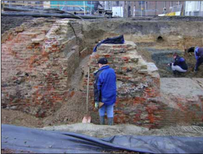
Fig. 7 Riolering aan de oostzijde.
