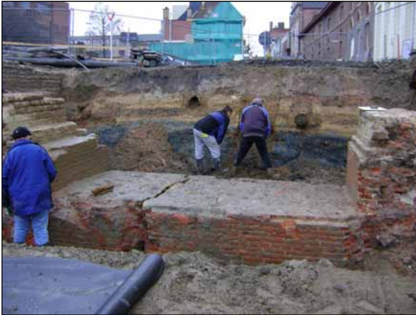
Fig. 5 Poortdoorgang in fundering (veldzijde).
