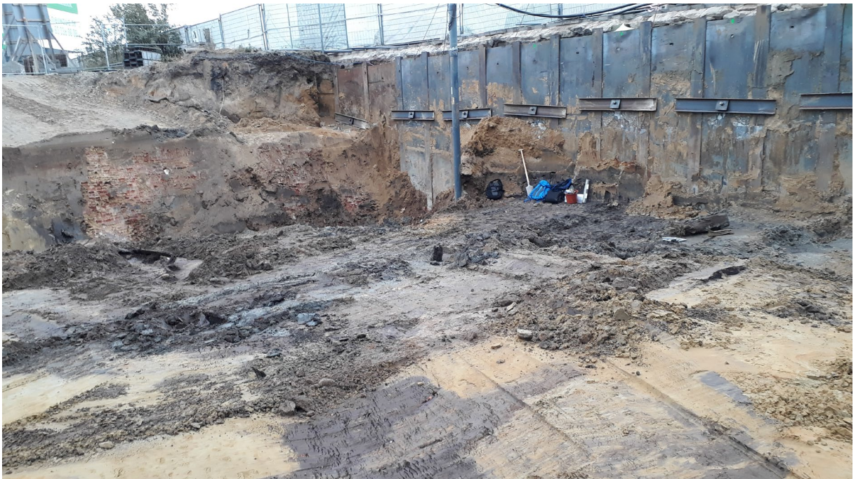
Figuur 8: Overzicht van de onderzoekszone vanuit het zuid-oosten.
