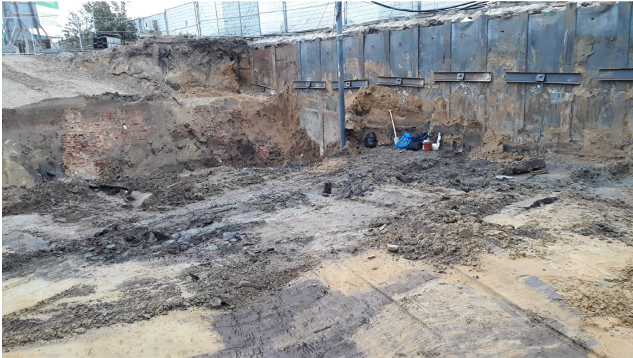
Figuur 4: Overzichtsfoto van de werkput vanuit het zuid-oosten.
