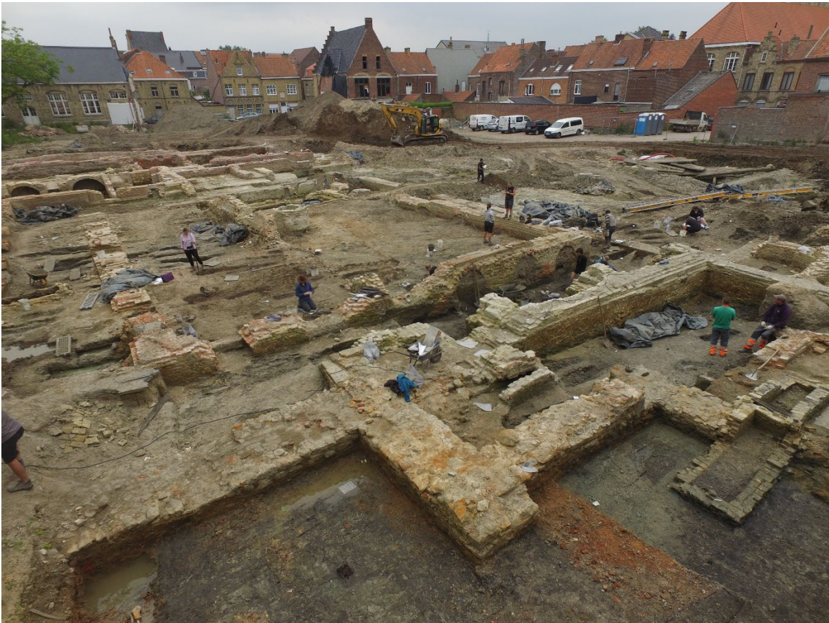
Fig. 4.6: Zicht van de funderingen in ijzerzandsteen van de kruisbeuk van de oudste kerk (vooraan op de foto). Rechts vooraan bevinden zich de twee grafkelders die doorheen deze fundering zijn geplaatst.
