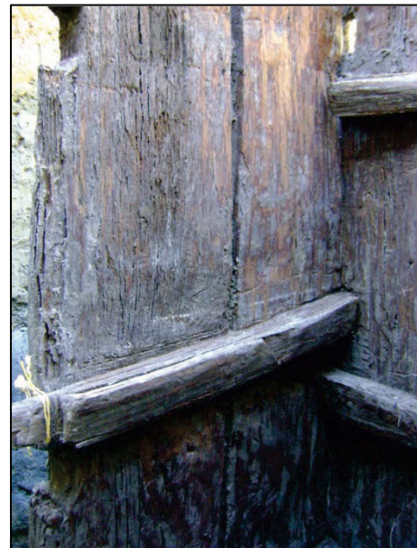
Fig. 21 Waterput 151. Detail van binnenzijde bekisting.
