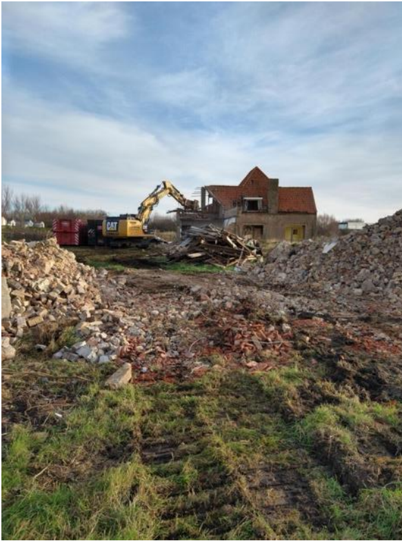
Figuur 1: Impressie van de afbraakwerken in november 2020 (© Provincie West-Vlaanderen, foto Glenn Gevaert).
