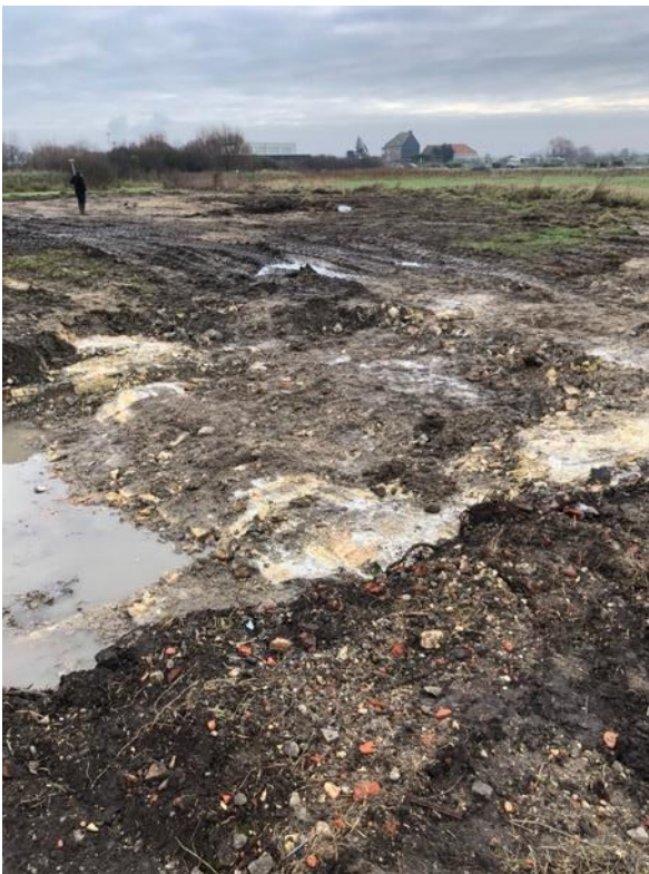
Figuur 2: De zone na de afbraakwerken. Centraal op de foto dazomen zware bakstenen constructies die vooral opvallen door de witte kleur van de gebruikte kalkmortel. Links daarvan bevindt zich de zone waarin grondwater staat omdat die iets dieper is uitgebroken vanwege de aanwezigheid van een betonnen kelder (© agentschap Onroerend Erfgoed, foto Marnix Pieters).
