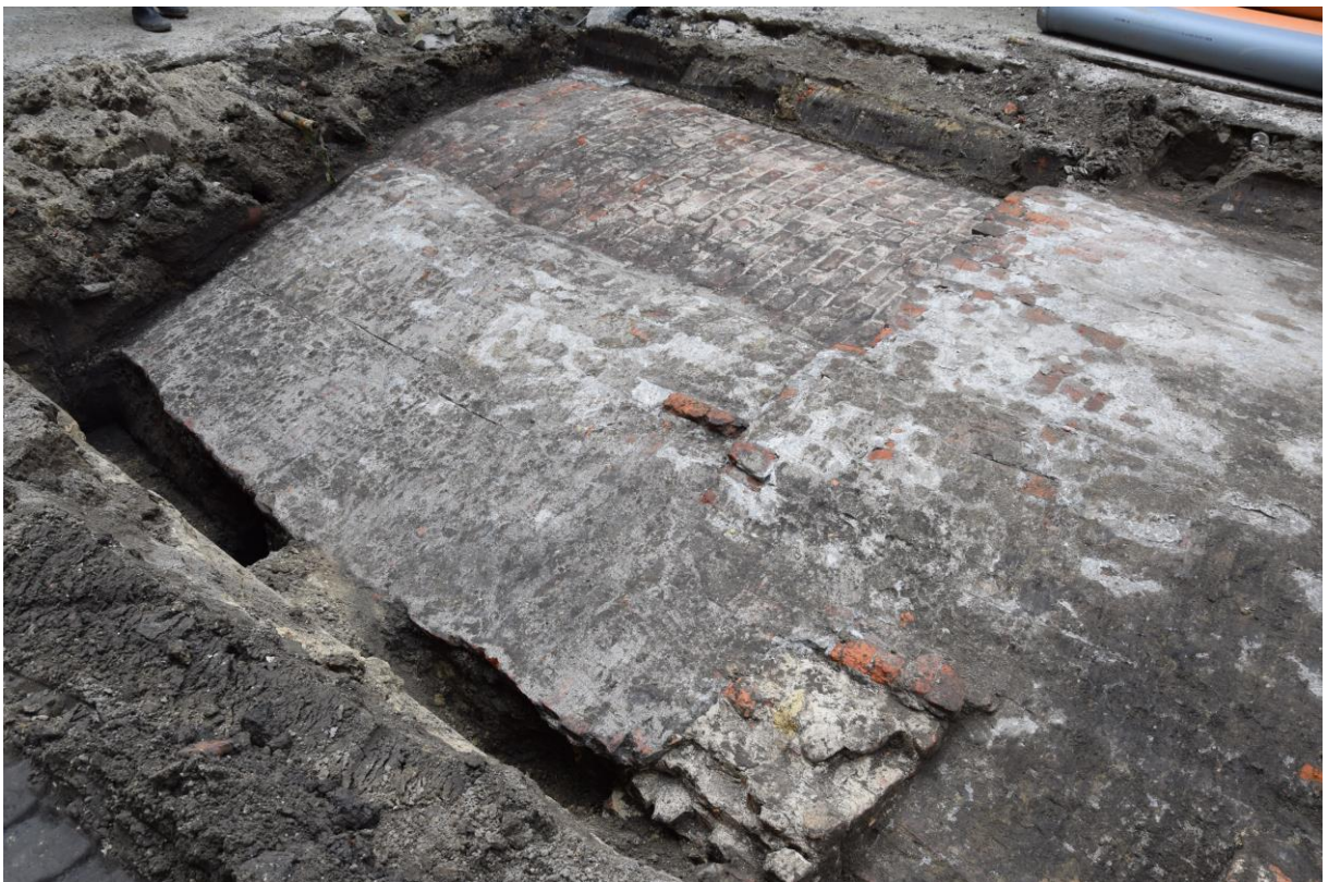
Figuur 17: De vrijgelegde gewelven. Zicht naar het noordwesten op het gewelf van de kleinere kelder, met overgang naar de grotere kelders rechts. Merk de tweede gewelflaag op de zuidelijke helft van het gewelf van de westelijke kelder. De rand van deze gewelflaag is niet afgewerkt en hangt een stuk over.
