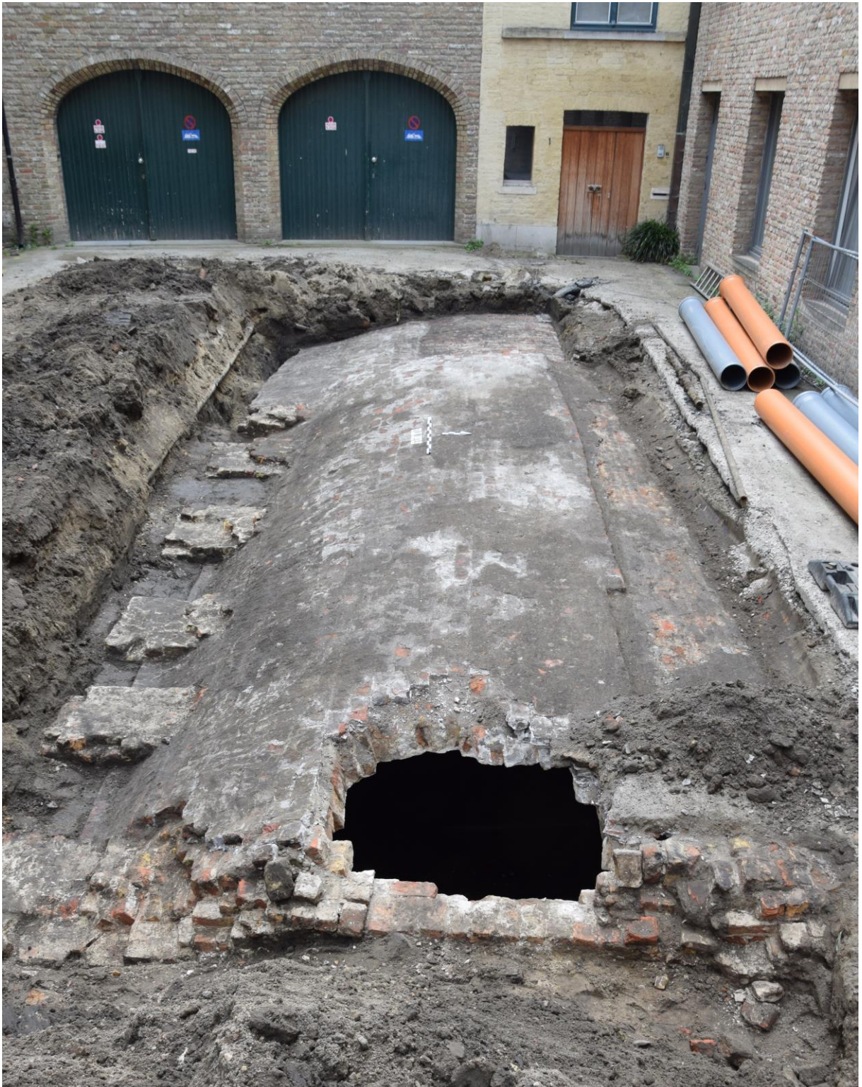
Figuur 8: Zicht op de opgekuiste gewelven en contouren van de dubbele straatkelder, naar het westen. Met achteraan rechts de voordeur van Rode-Haanstraat 1.
