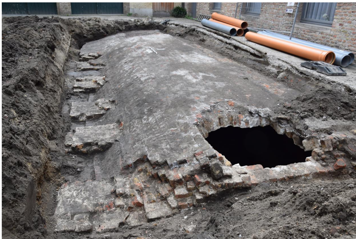
Figuur 12: Zicht naar het westen op het vrijgelegde gewelf van de oostelijke, grote kelder met aan de zuidkant de steunberen.
