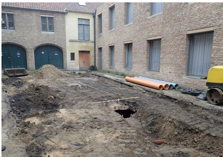
Figuur 1: De terreinsituatie vóór de start van het terreinonderzoek. Het bij de werken door de graafmachine ingeslagen gat in het gewelf was de aanleiding voor de toevalsvondst. Zicht naar het westen. Foto door Thomas Wets, Monumentenzorg en Erfgoedzaken (Stad Brugge).
