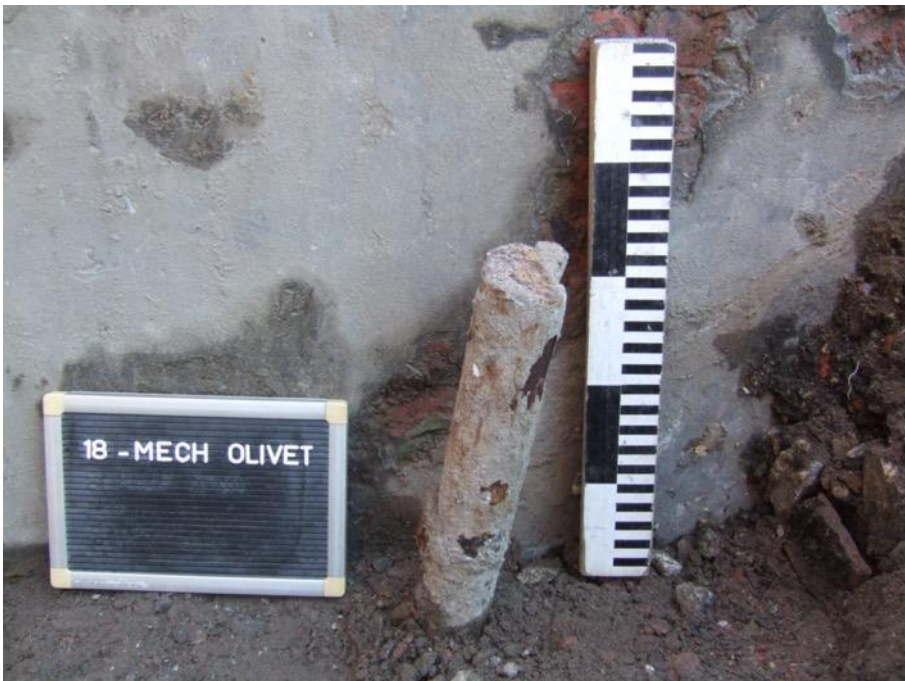
Figuur 24: Detail aanwezigheid ijzeren buis ter hoogte van ronde constructie. De functie is onduidelijk maar staat ongetwijfeld in verband met het gebruik van de gastank. © agentschap Onroerend Erfgoed. Foto: Marc Brion.
