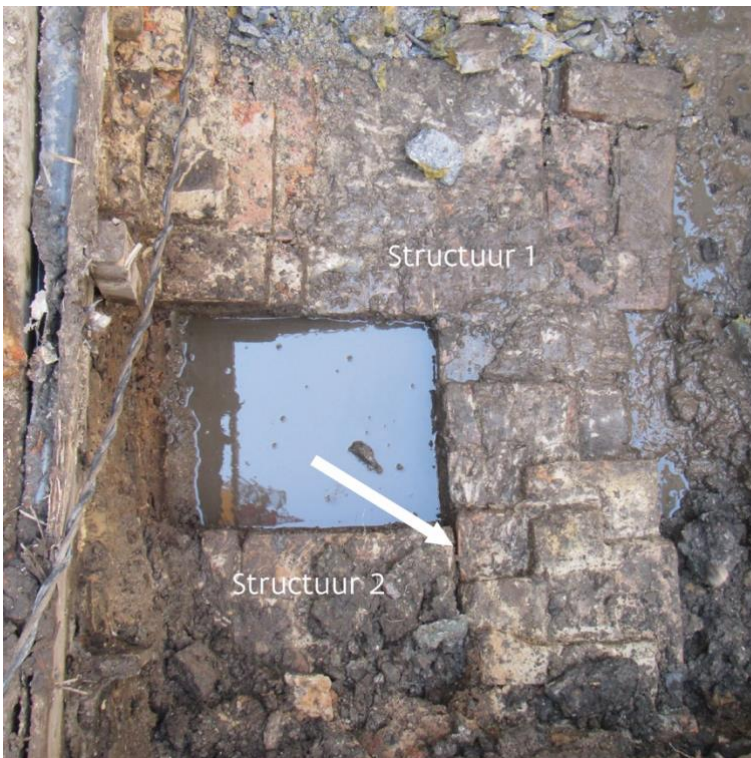
Figuur 14: Zicht op de muurresten, gericht naar het zuiden, met aanduiding van de koude bouwnaad tussen muurstructuren 1 en 2.
