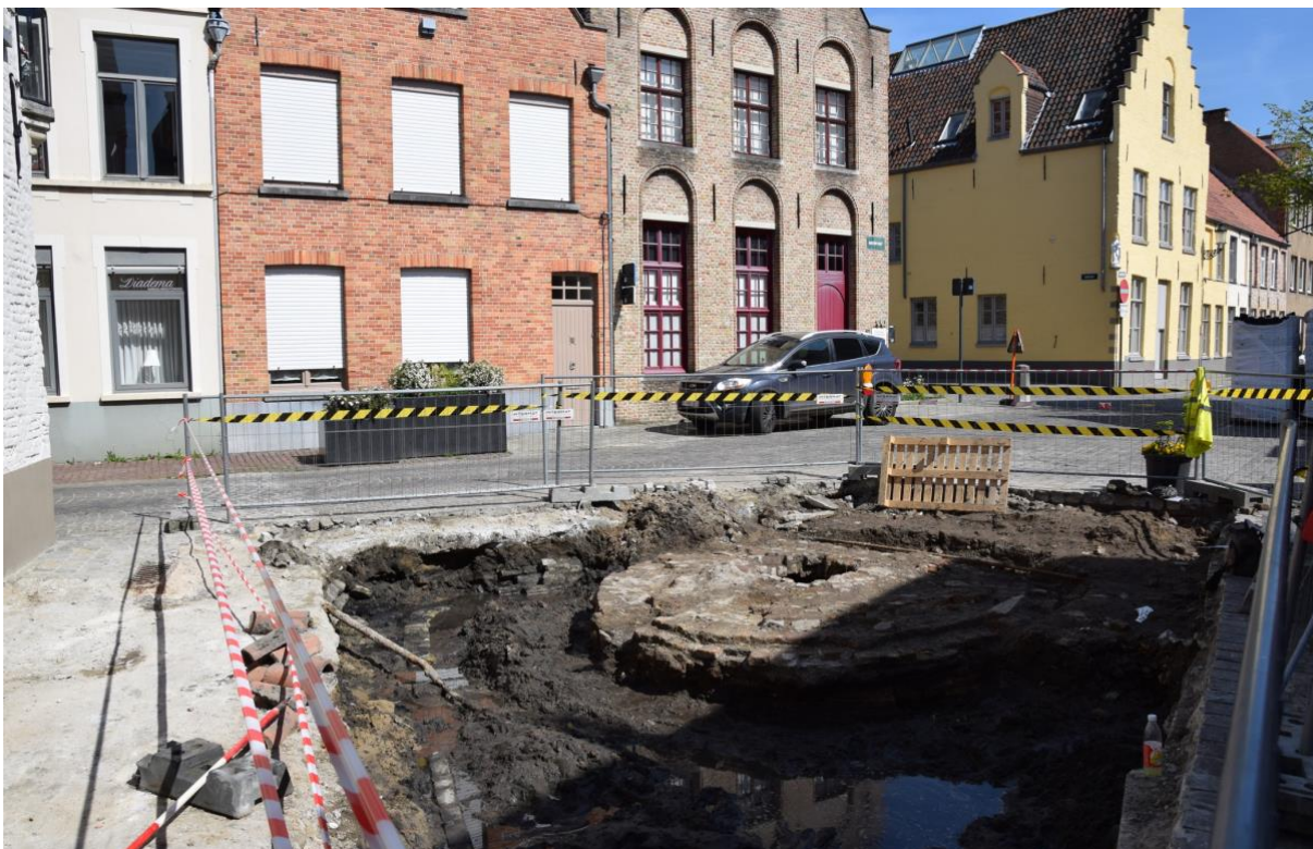
Figuur 1: De vindplaats, zicht naar het zuidoosten, naar het kruispunt van de Ganzenstraat met de Hooistraat: de werkput met centraal de waterput met bakstenen koepel.
