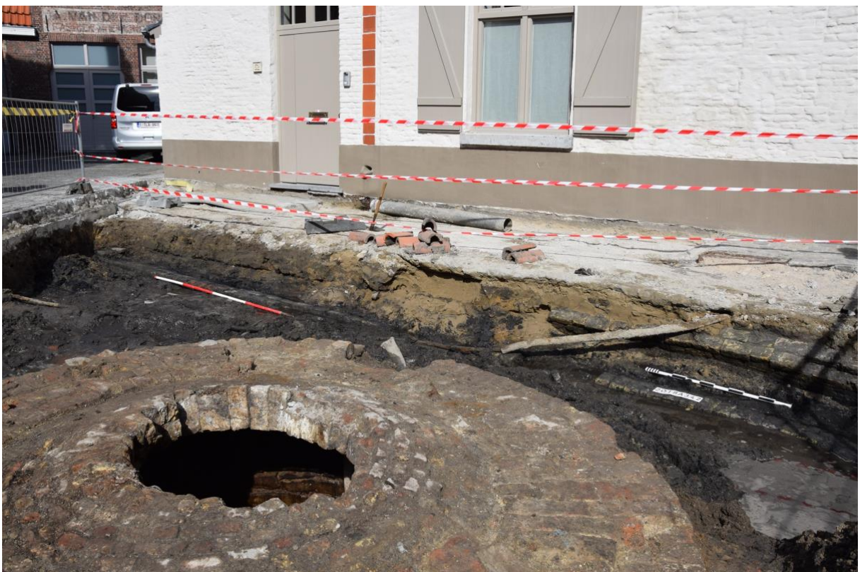
Figuur 22: Net ten noorden van de waterput werd, langs de noordzijde van de werkput, nog een oude riool aangetroffen. De schaallatten markeren het tracé van het bakstenen riool. Zicht naar het noordwesten.
