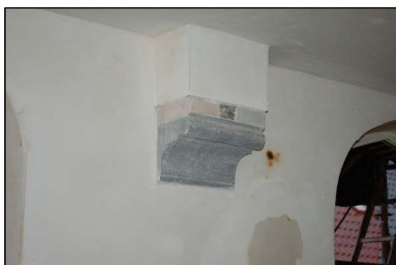
FIG. 37 Eén van de kraagstenen op de eerste verdieping.
