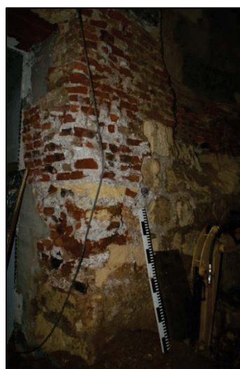
FIG. 29 Werkput 2: de noord-zuid lopende muur in Maastrichtersteen, die pas tijdens een later bezoek werd gezien.
