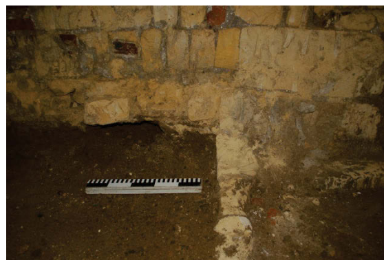
FIG. 38 De nieuwe zuidelijke fundering in Maastrichtersteen aangelegd over een oudere fundering.
