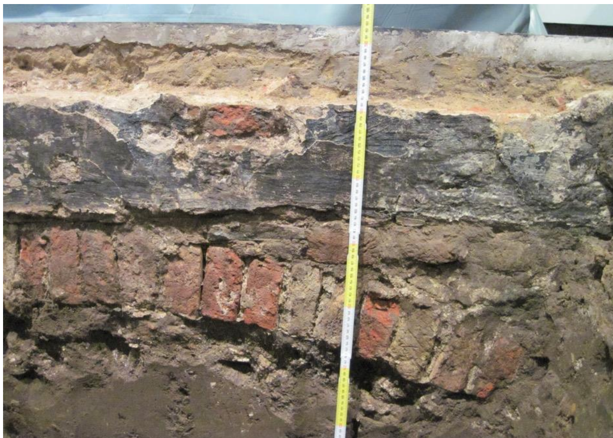
Figuur 19: Detail van de muuropbouw met pleisterwerk (S6) op de onderliggende spaarboog (S2) (© Raakvlak).
