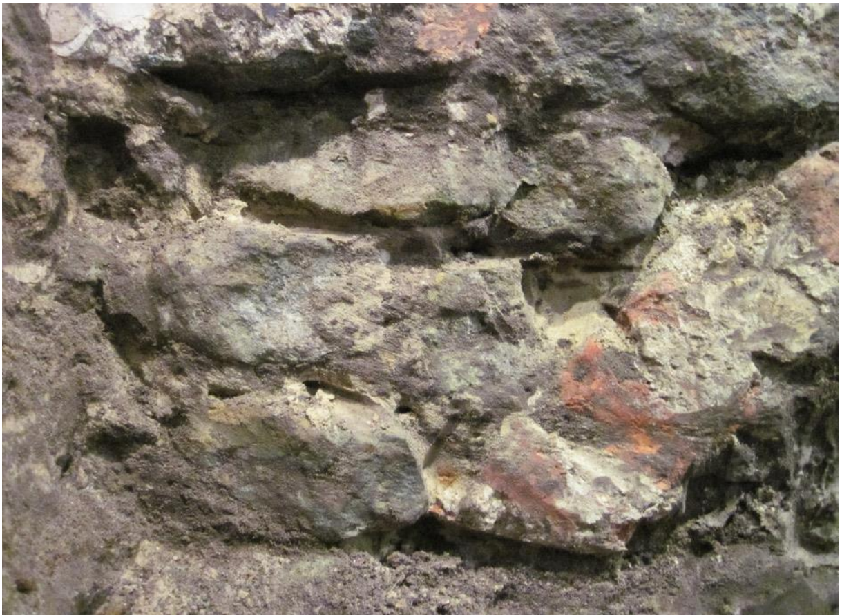
Figuur 17: Detail van aansluiting van de veldstenen muur (S1) op de spaarboog (S2) (© Raakvlak).
